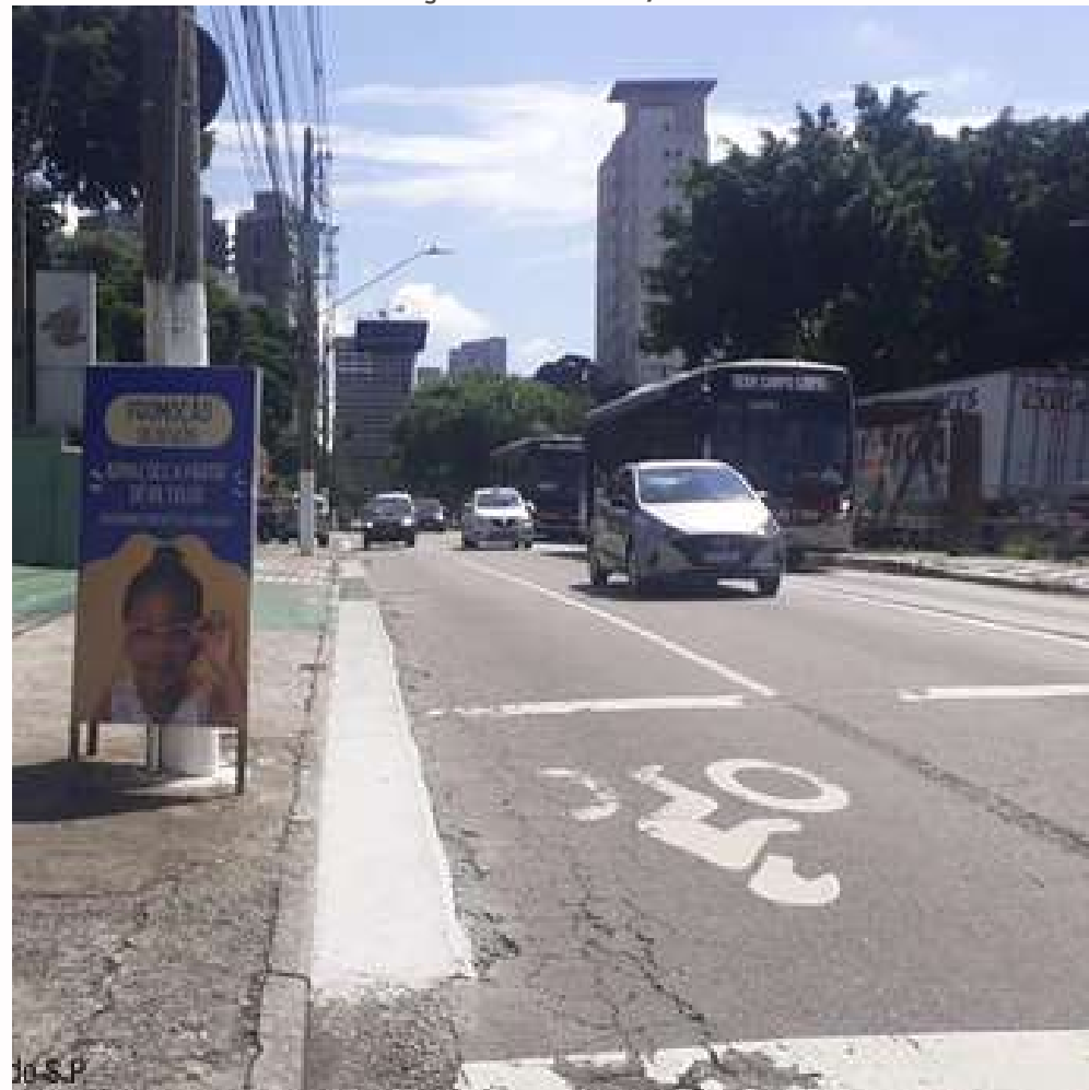
FOTO EM EXECUÇÃO: FEV/2024
