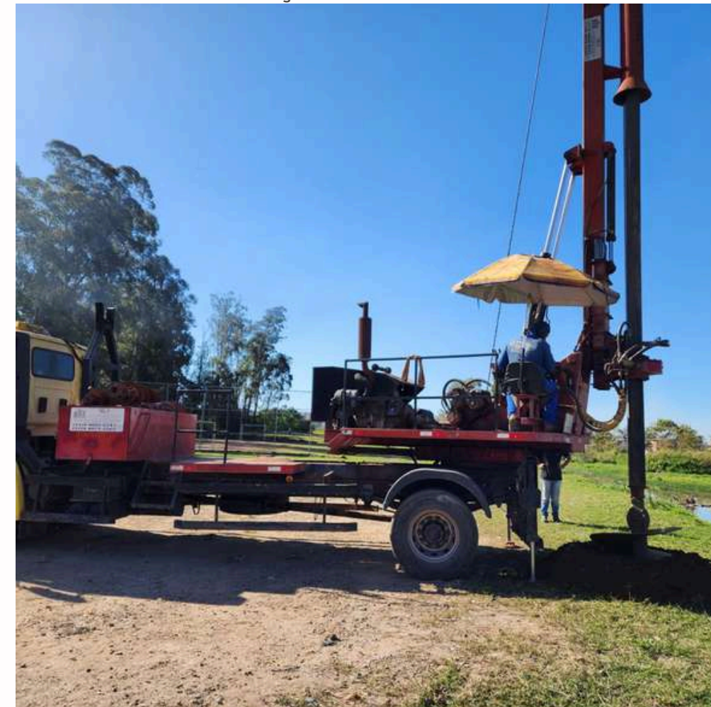
FOTO EM EXECUÇÃO:
