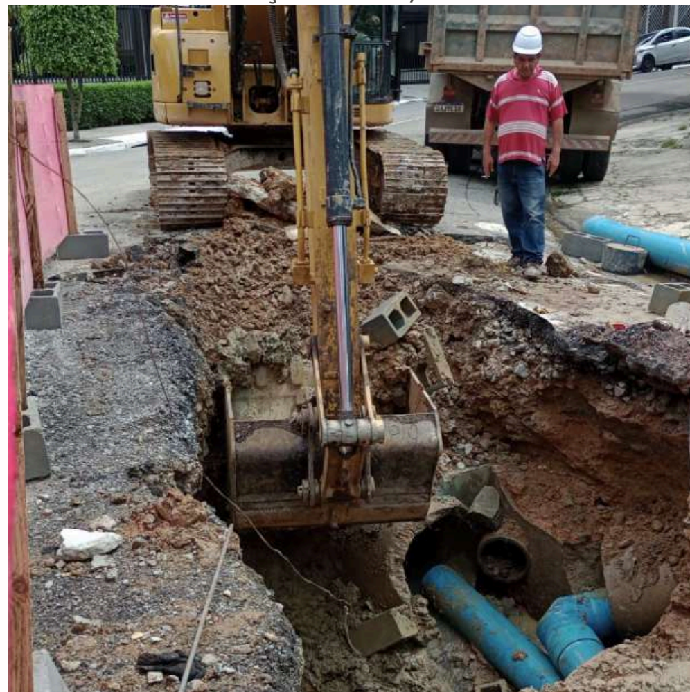
FOTO EM EXECUÇÃO: FEV/2024
