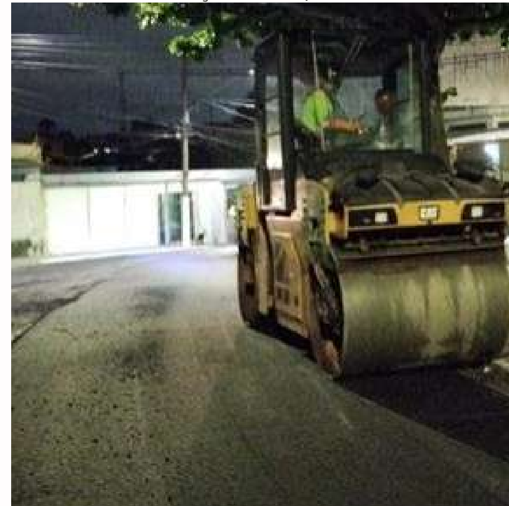
FOTO EM EXECUÇÃO: FEV/2024
