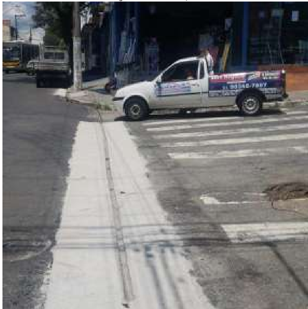
FOTO EM EXECUÇÃO: MAR/2023
