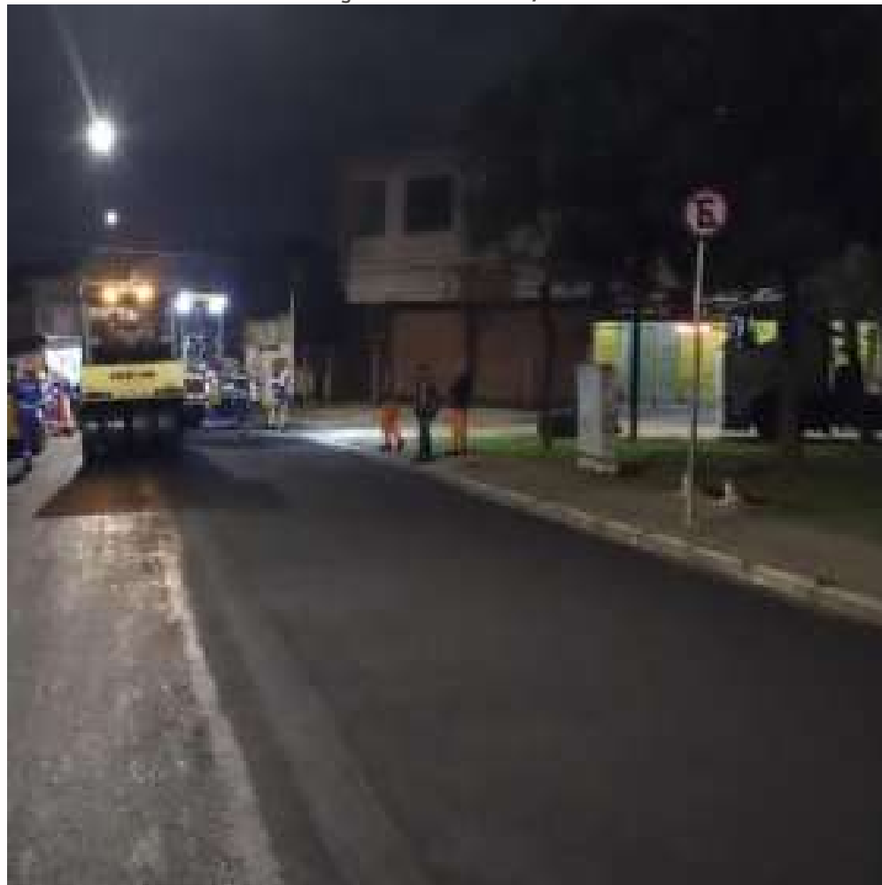
FOTO EM EXECUÇÃO: MAR/2024
