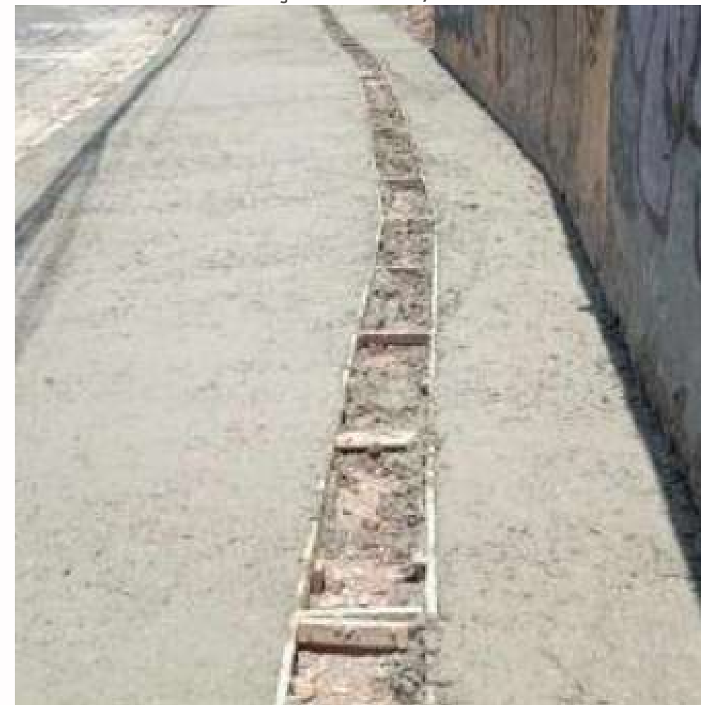
FOTO EM EXECUÇÃO: FEV/2024
