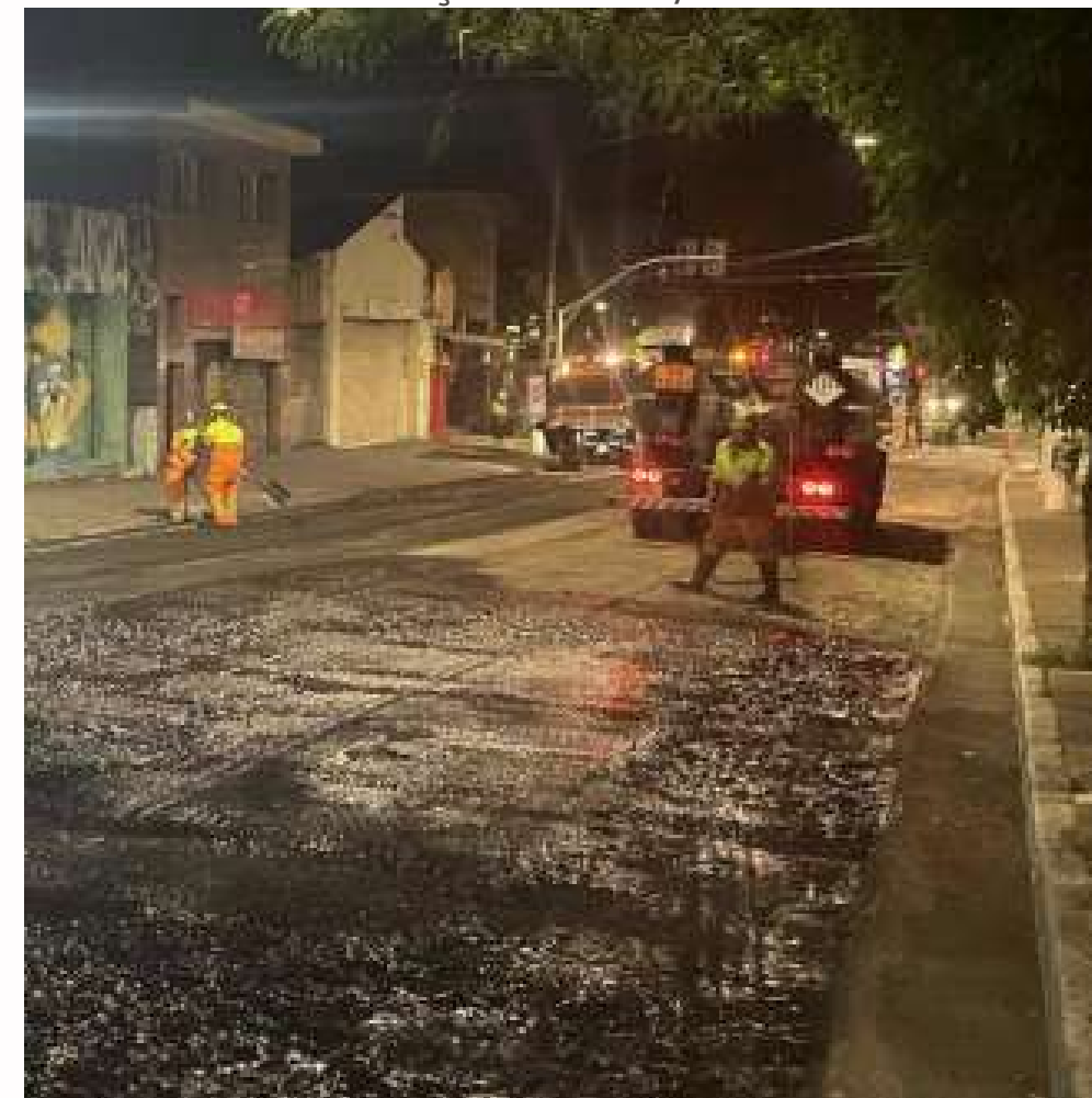
FOTO EM EXECUÇÃO: MAR/2024
