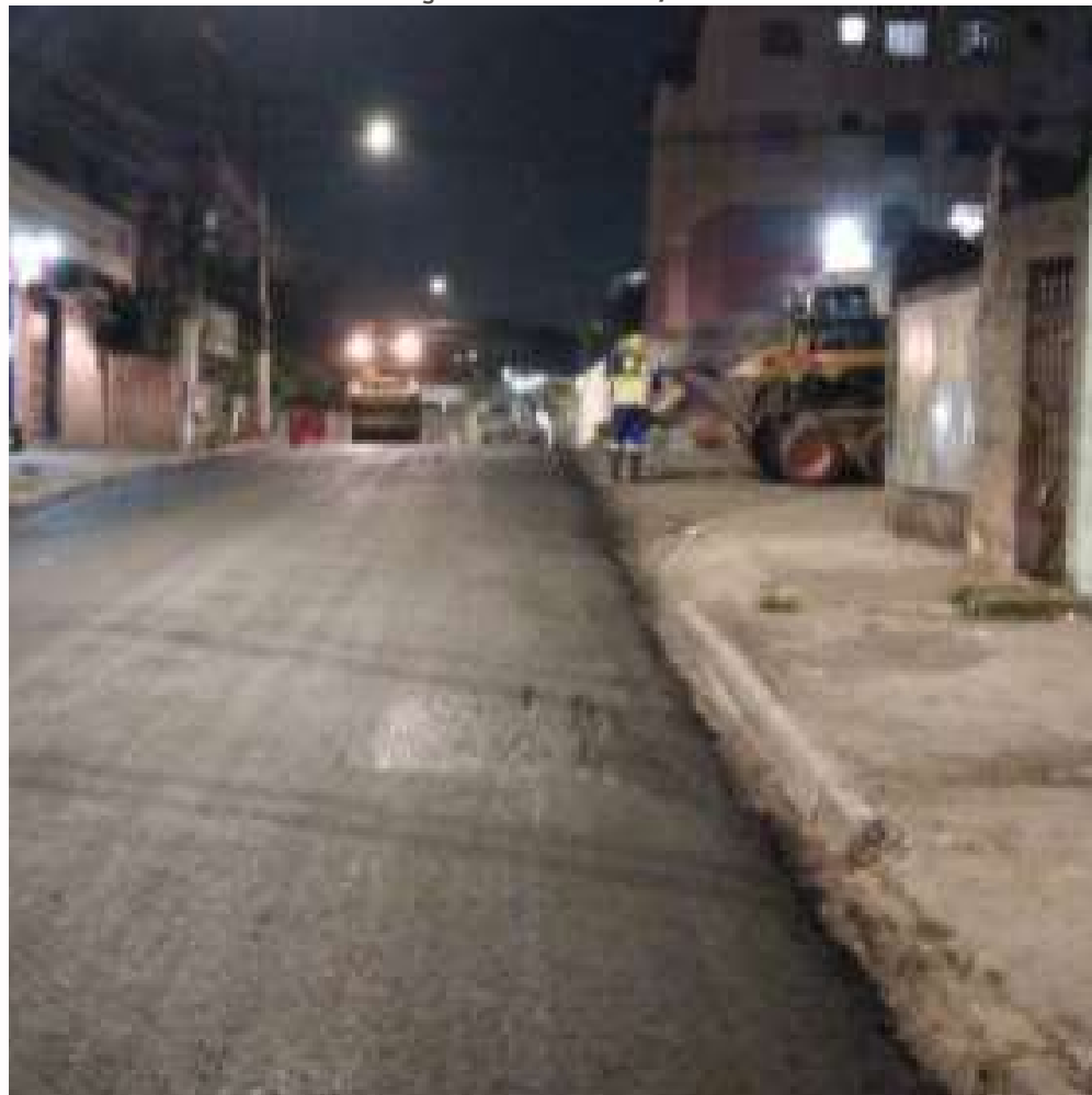
FOTO EM EXECUÇÃO: MAR/2024
