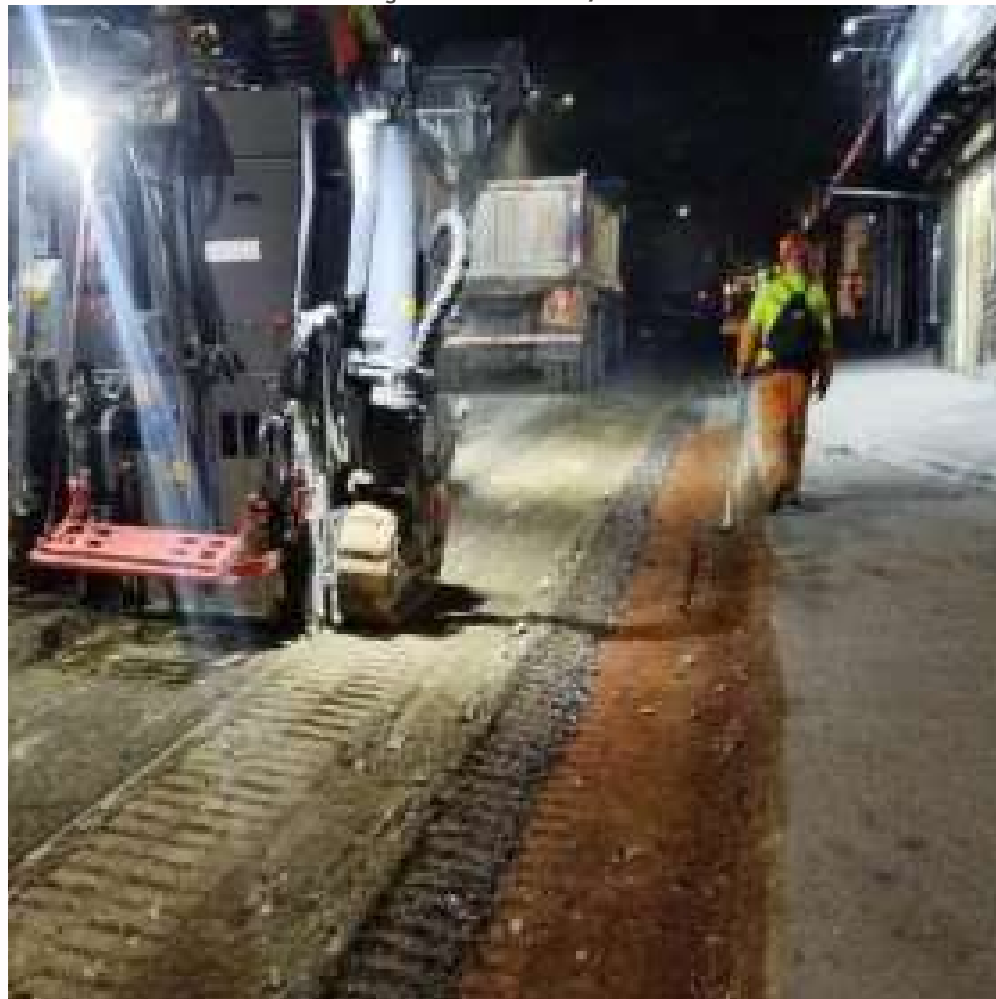
FOTO EM EXECUÇÃO: FEV/2024
