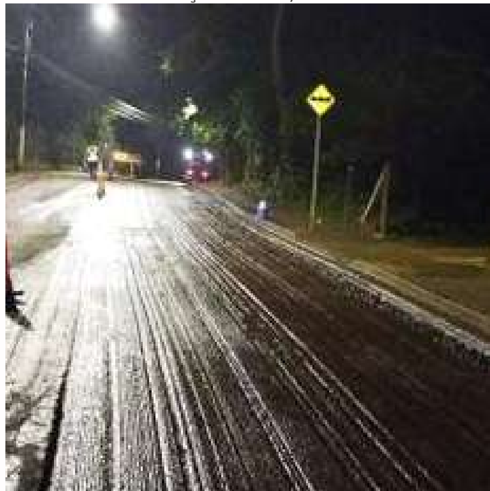
FOTO EM EXECUÇÃO: FEV/2024
