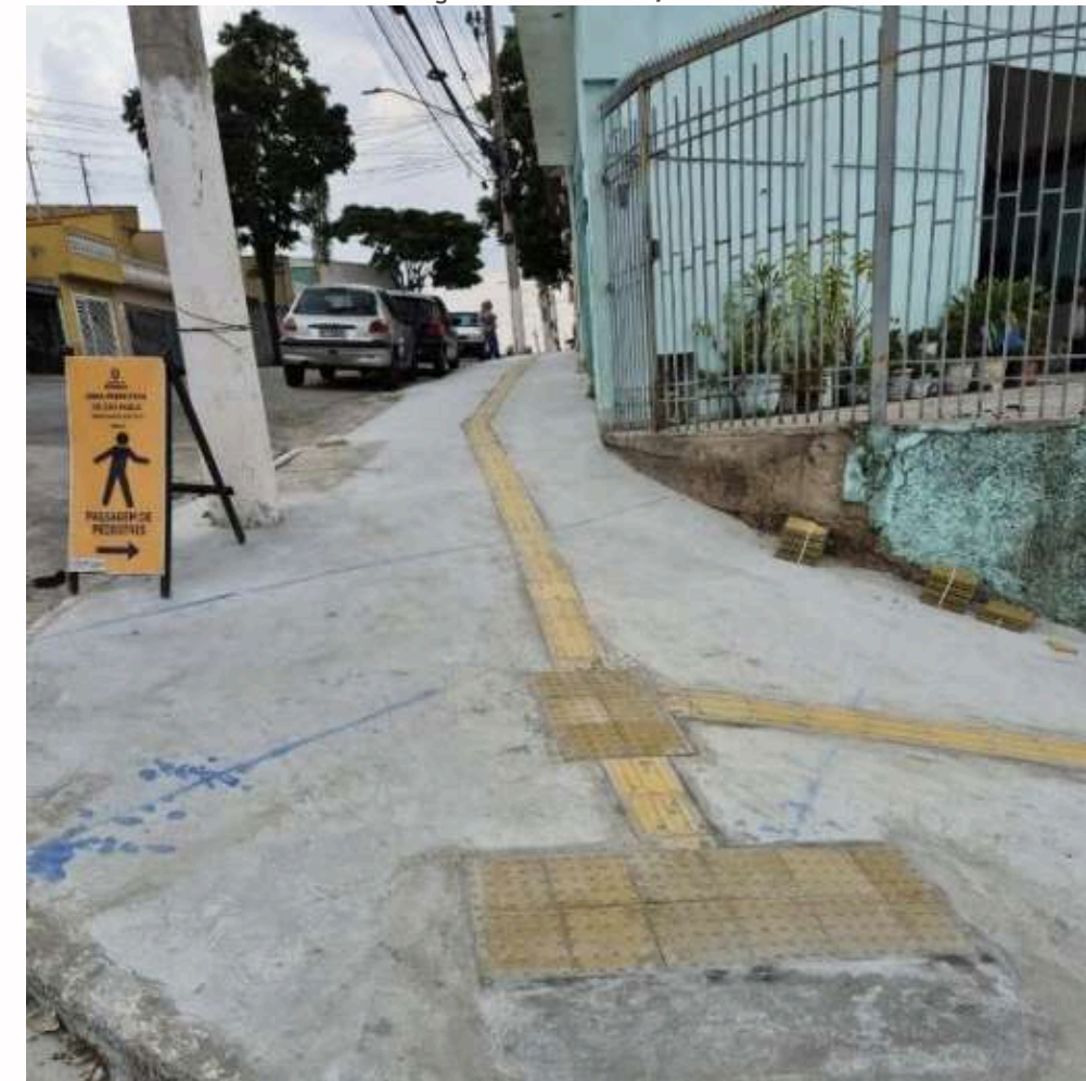
FOTO EM EXECUÇÃO: FEV/2024
