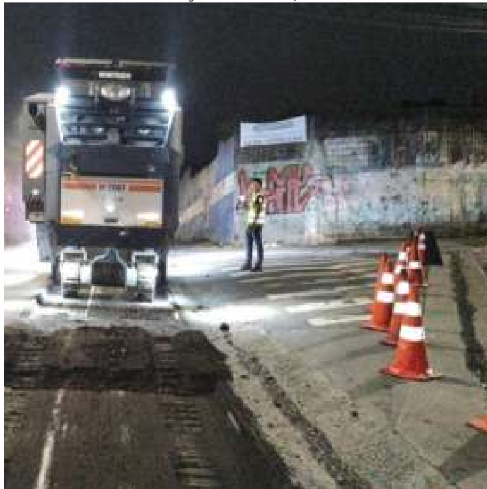
FOTO EM EXECUÇÃO: MAR/2024
