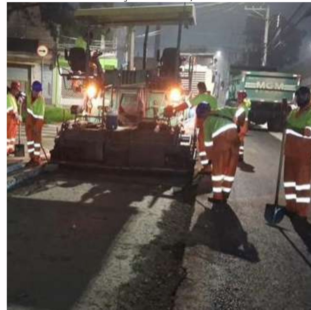
FOTO EM EXECUÇÃO: MAR/2024
