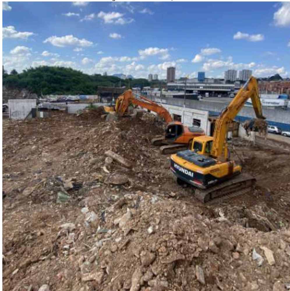
FOTO EM EXECUÇÃO: FEV/2024
