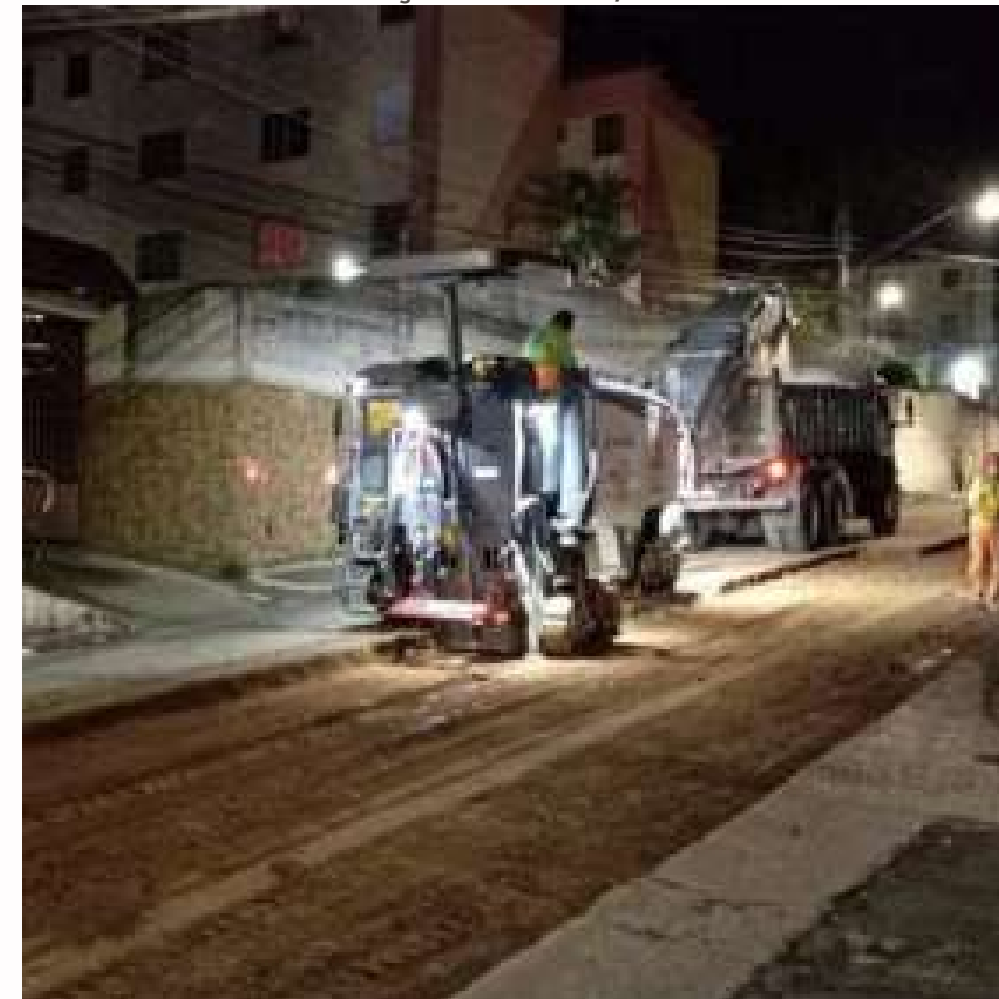
FOTO EM EXECUÇÃO: MAR/2024
