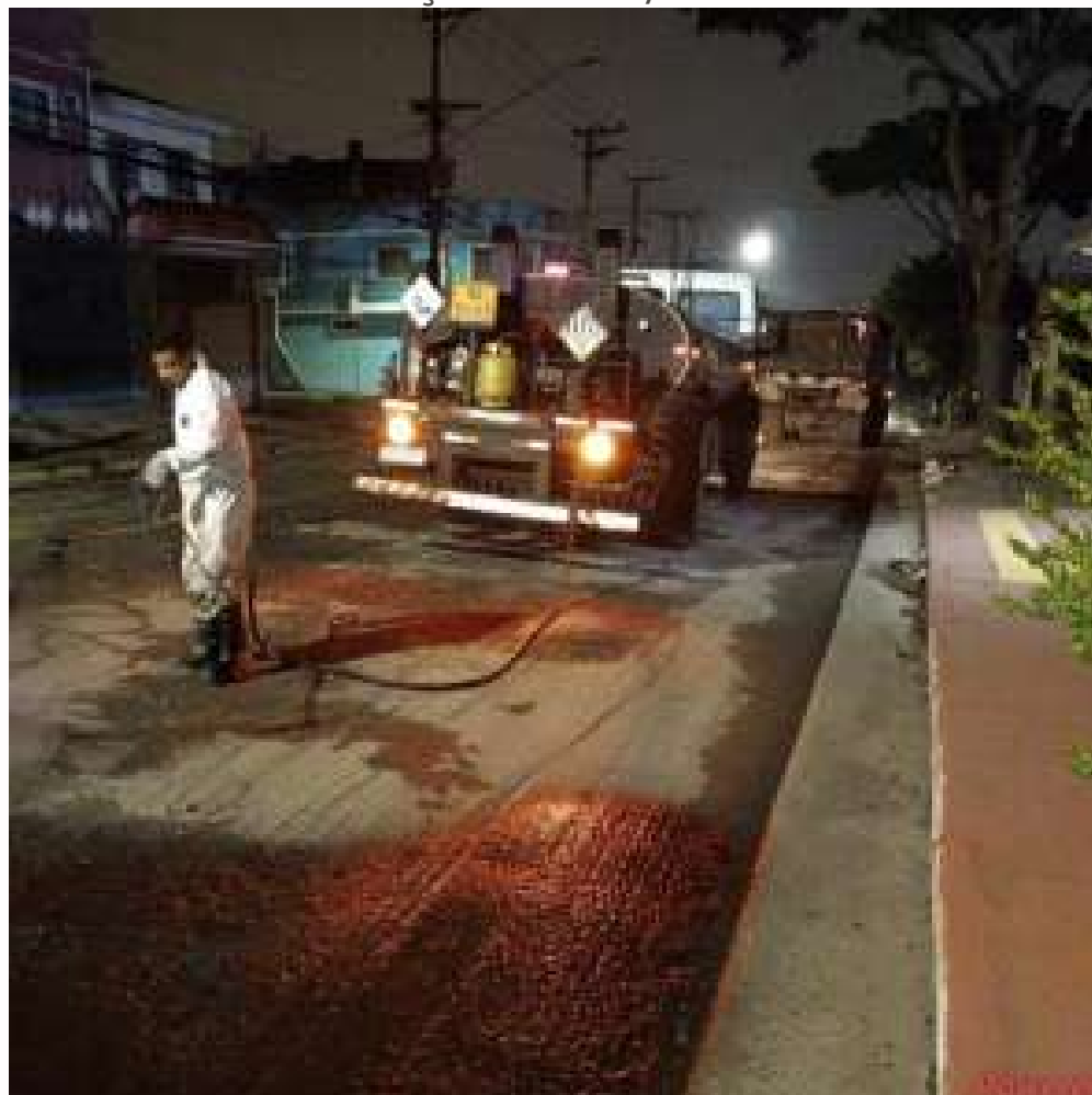
FOTO EM EXECUÇÃO: FEV/2024
