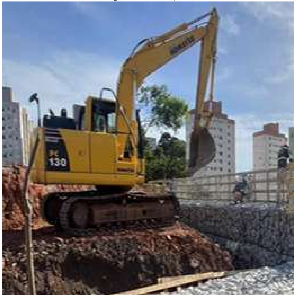
FOTO EM EXECUÇÃO: JAN/2024
