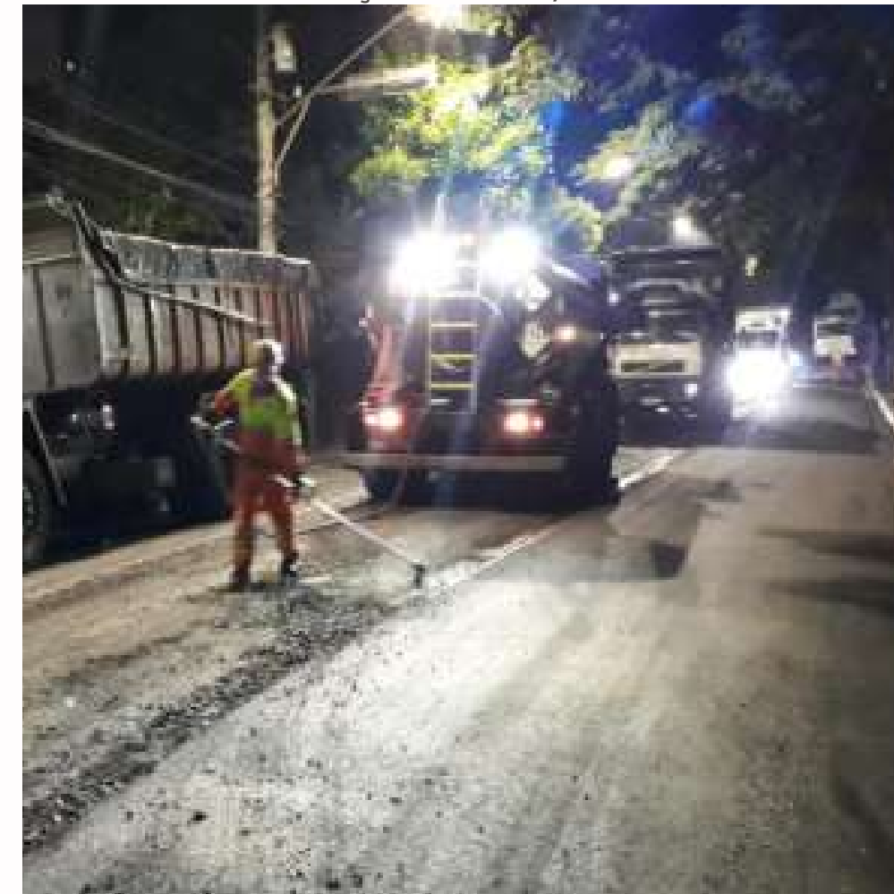
FOTO EM EXECUÇÃO: MAR/2024
