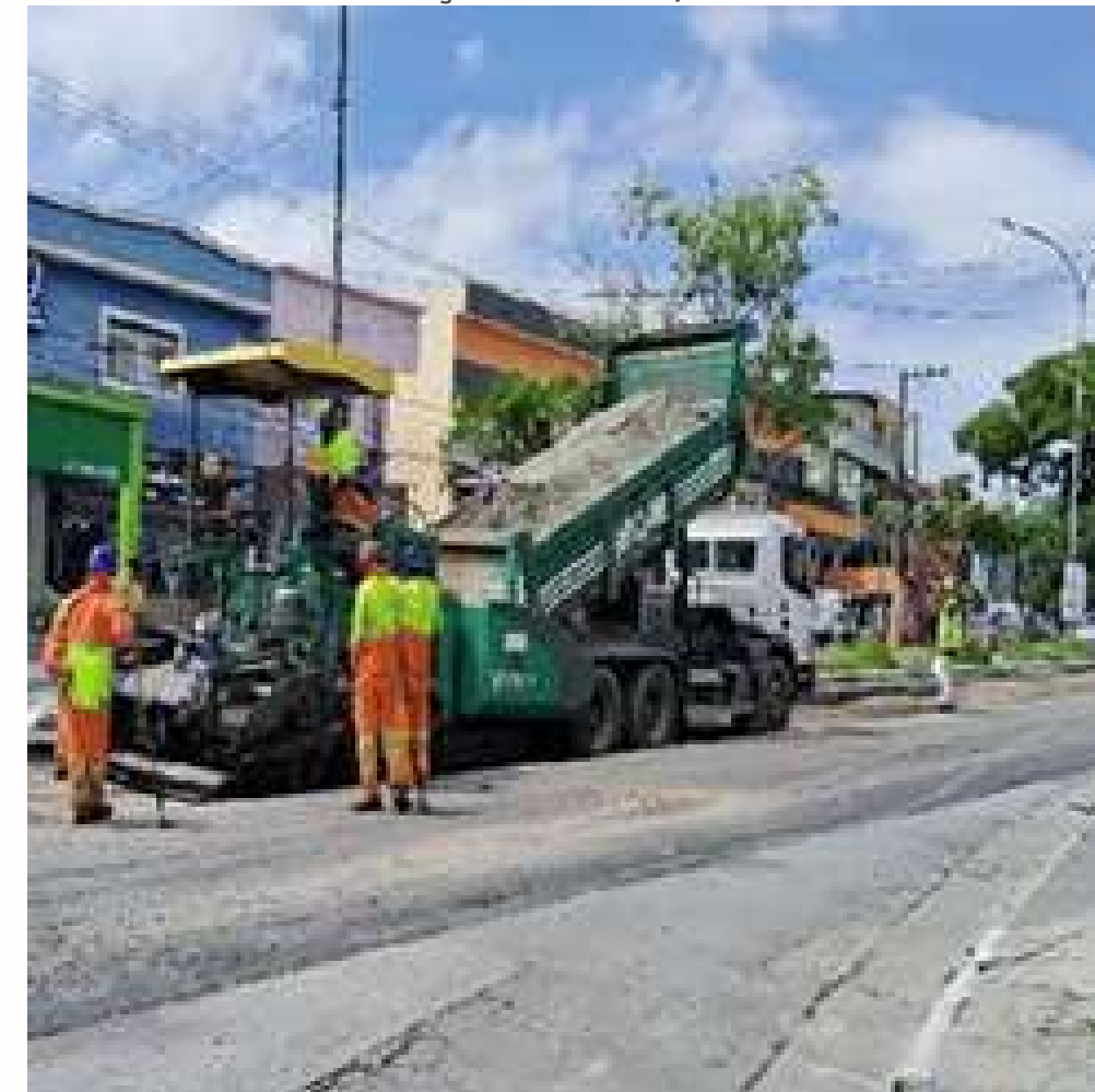
FOTO EM EXECUÇÃO: MAR/2024
