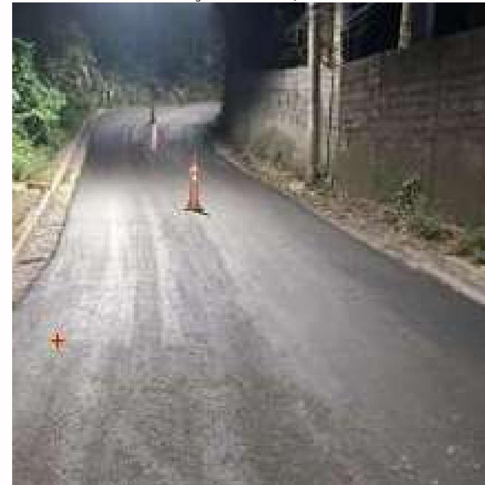
FOTO EM EXECUÇÃO: FEV/2024
