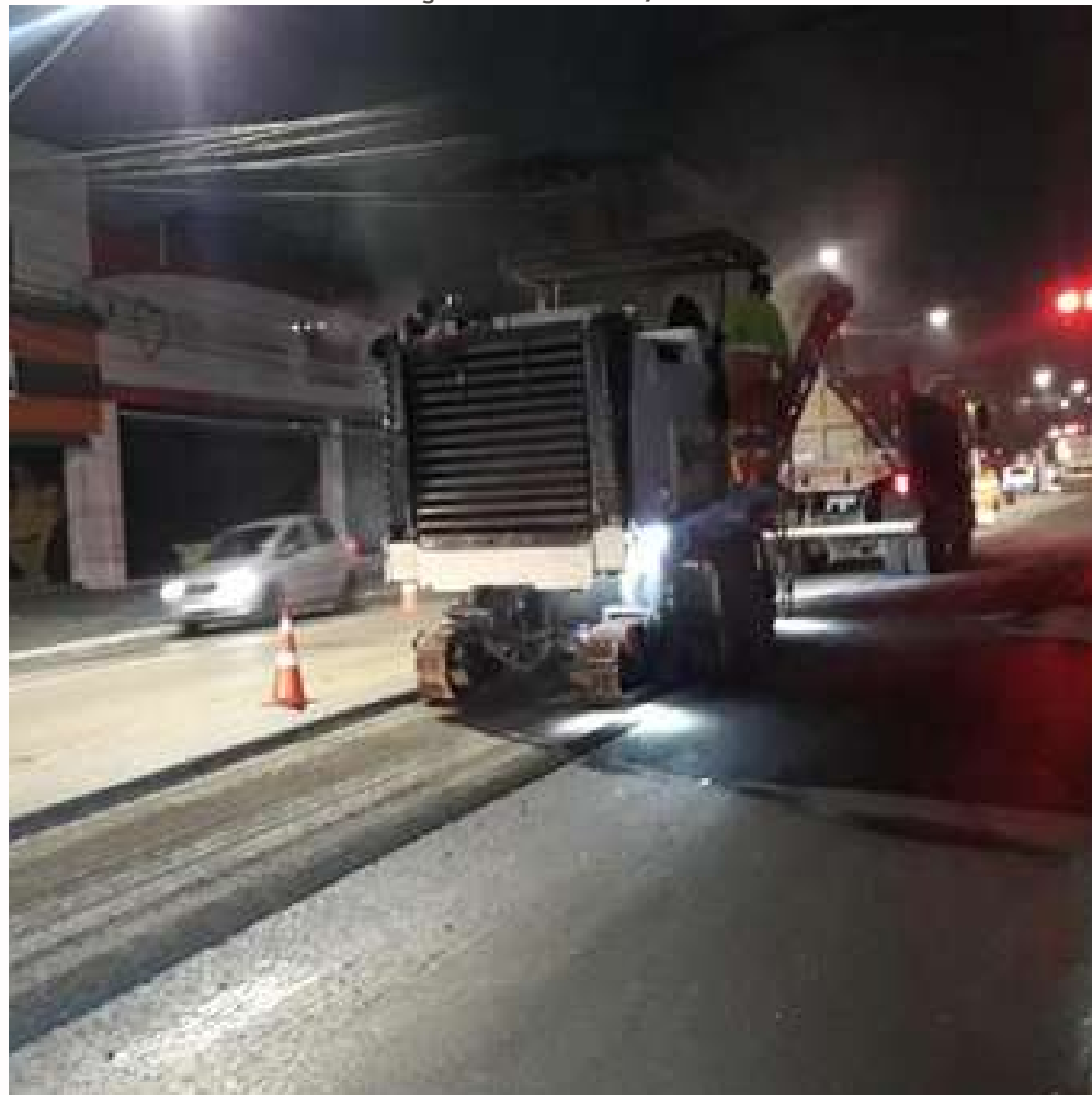
FOTO EM EXECUÇÃO: FEV/2024
