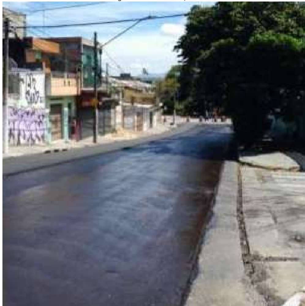
FOTO EM EXECUÇÃO: MAR/2024
