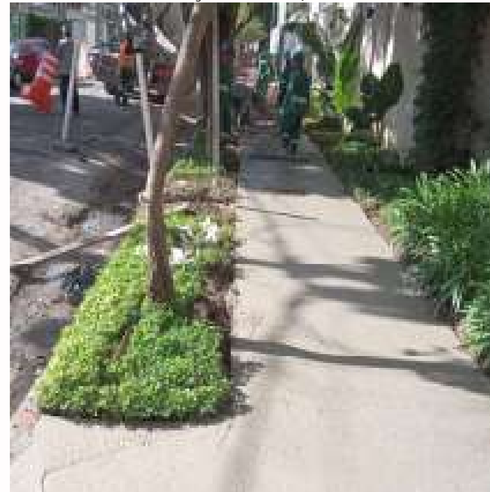
FOTO EM EXECUÇÃO: MAR/2024
