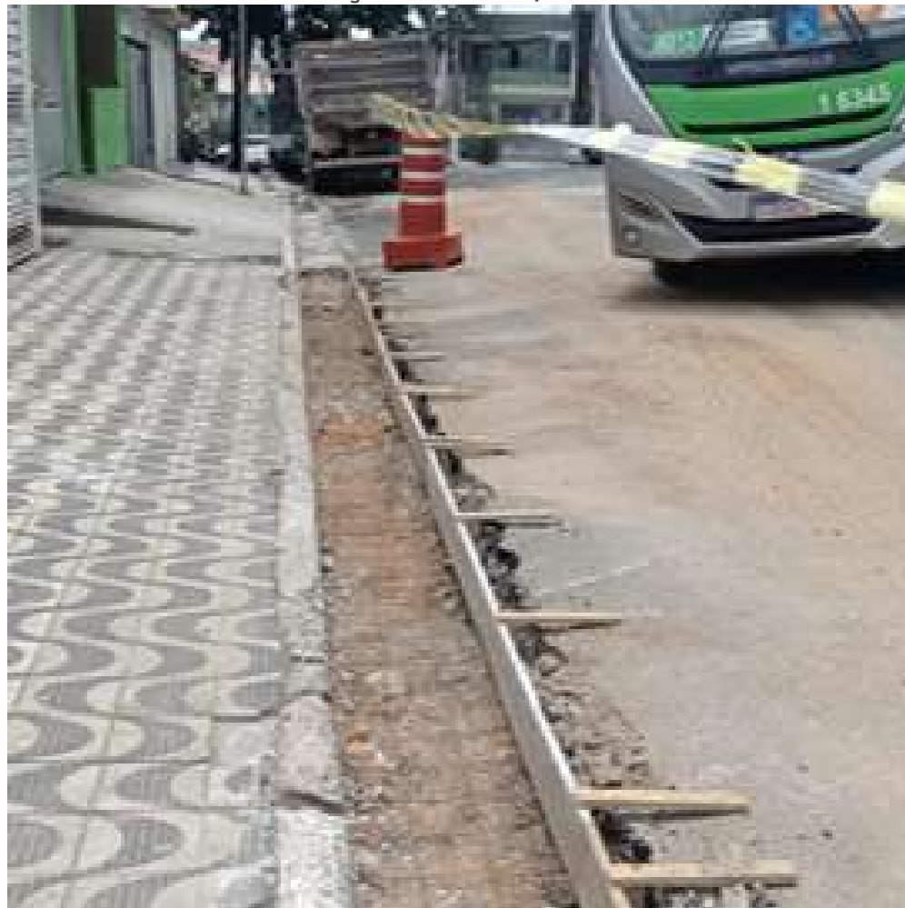
FOTO EM EXECUÇÃO: FEV/2024
