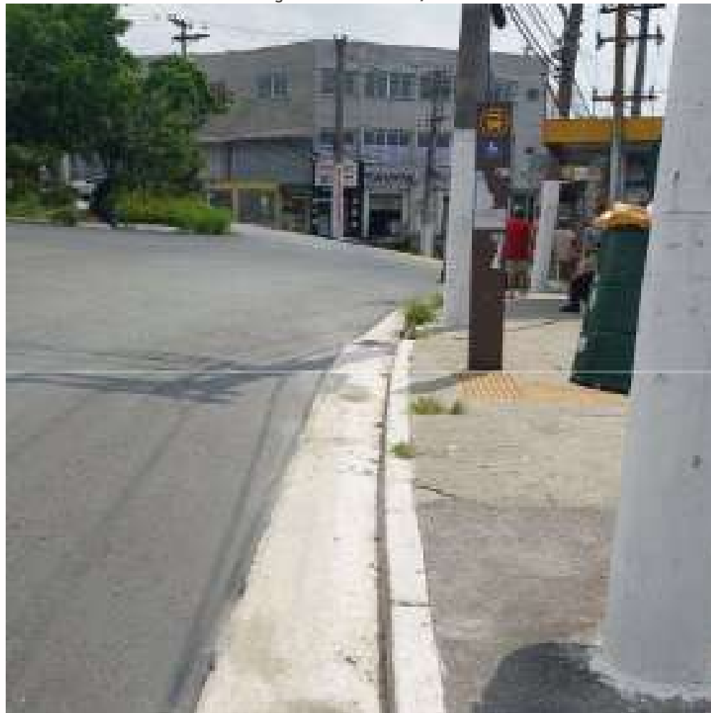
FOTO EM EXECUÇÃO: FEV/2024
