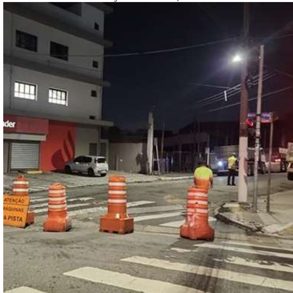
FOTO EM EXECUÇÃO: MAR/2024
