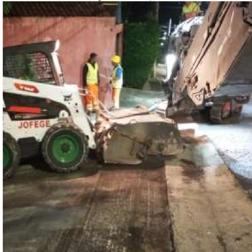
FOTO EM EXECUÇÃO: FEV/2024
