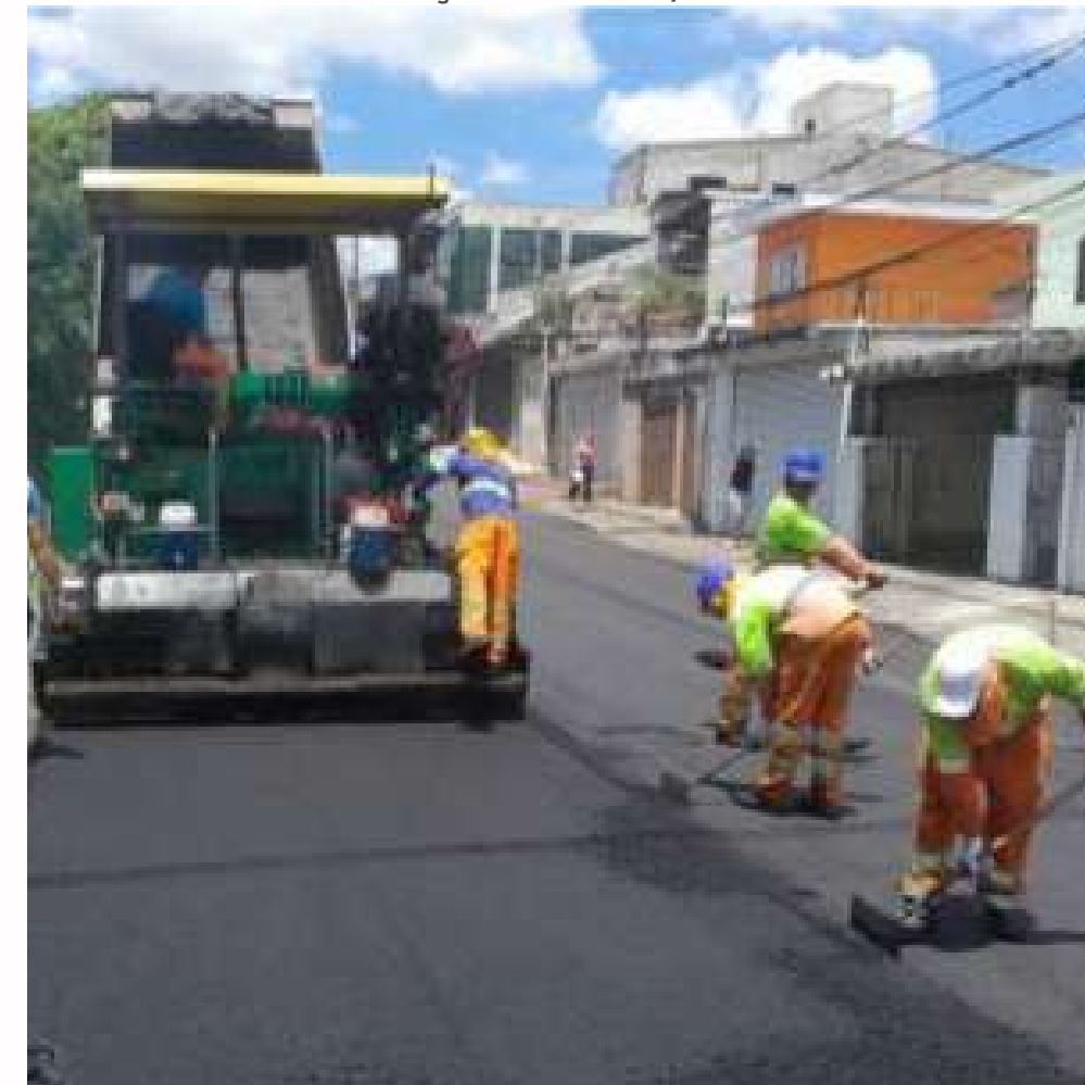
FOTO EM EXECUÇÃO: MAR/2024
