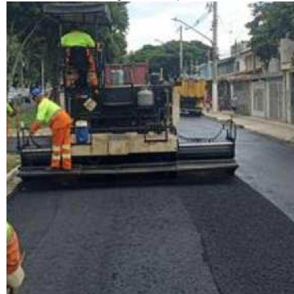
FOTO EM EXECUÇÃO: FEV/2024
