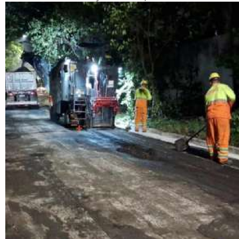
FOTO EM EXECUÇÃO: FEV/2024
