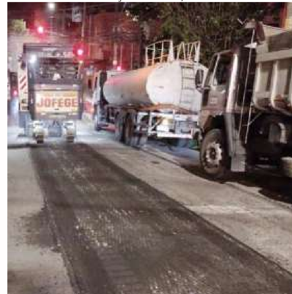
FOTO EM EXECUÇÃO: MAR/2024
