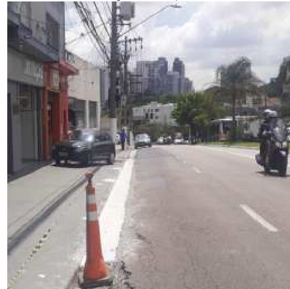
FOTO EM EXECUÇÃO: FEV/2024
