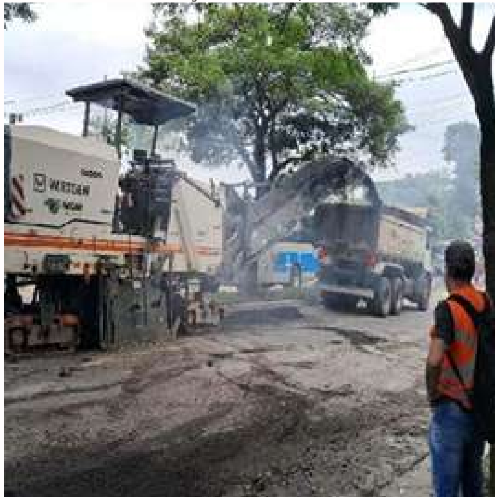
FOTO EM EXECUÇÃO: MAR/2024
