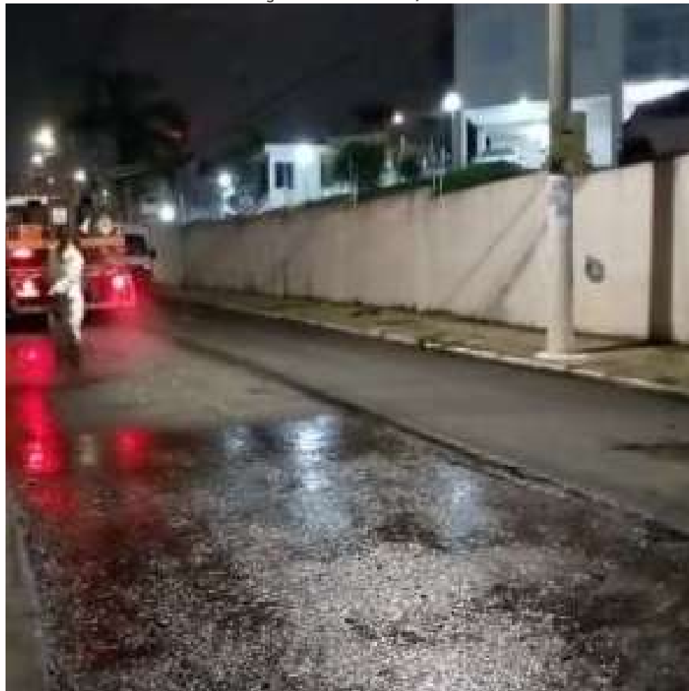
FOTO EM EXECUÇÃO: MAR/2024
