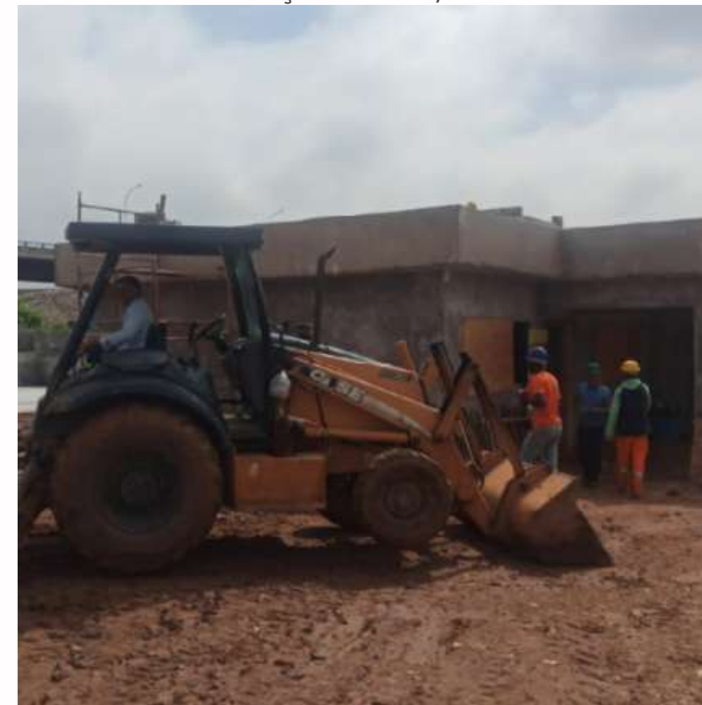
FOTO EM EXECUÇÃO: MAR/2024
