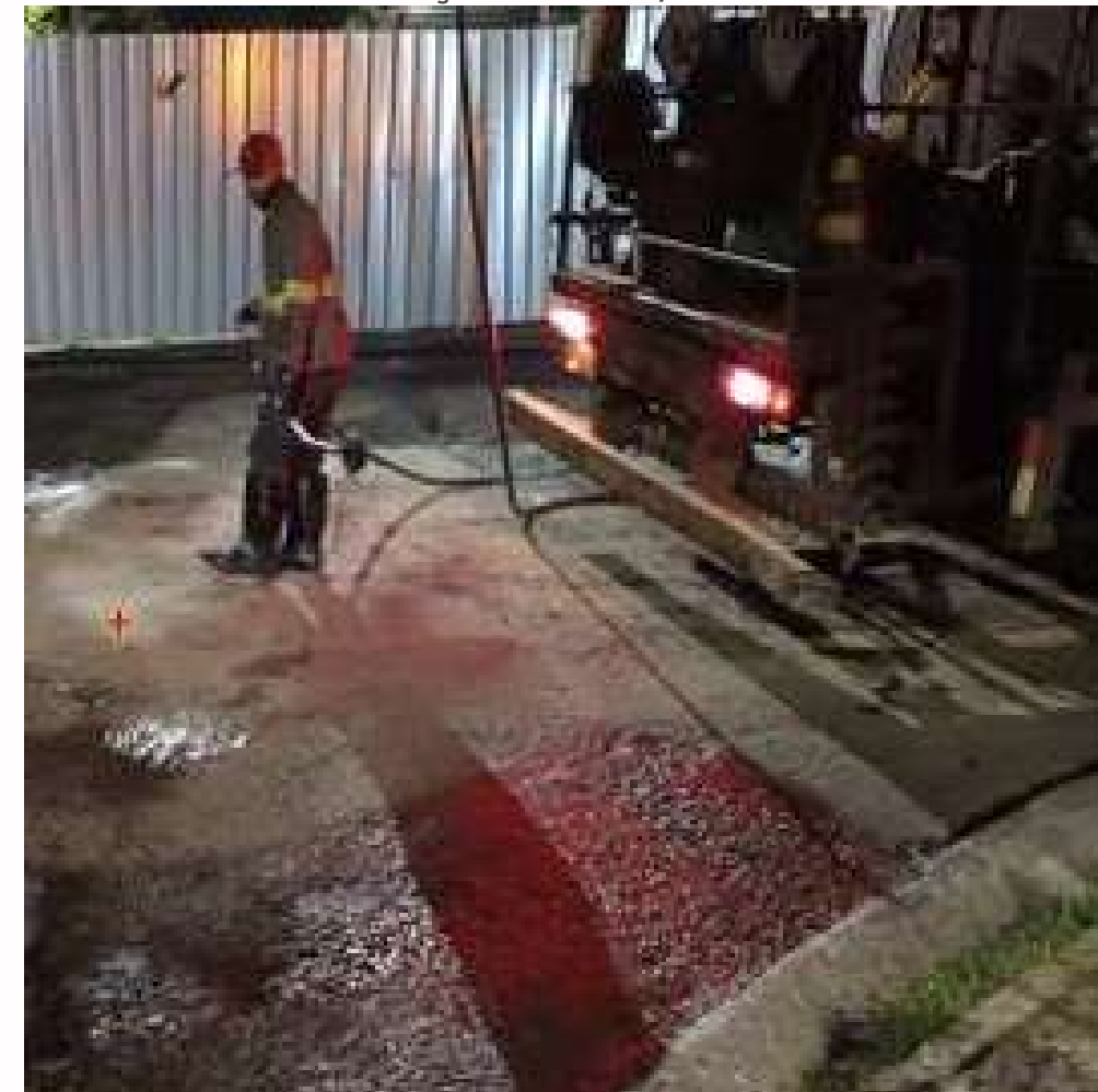
FOTO EM EXECUÇÃO: FEV/2024
