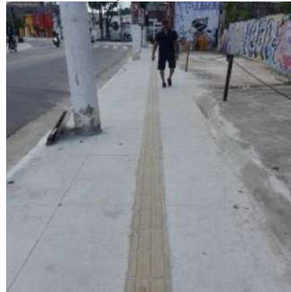
FOTO EM EXECUÇÃO: FEV/2024
