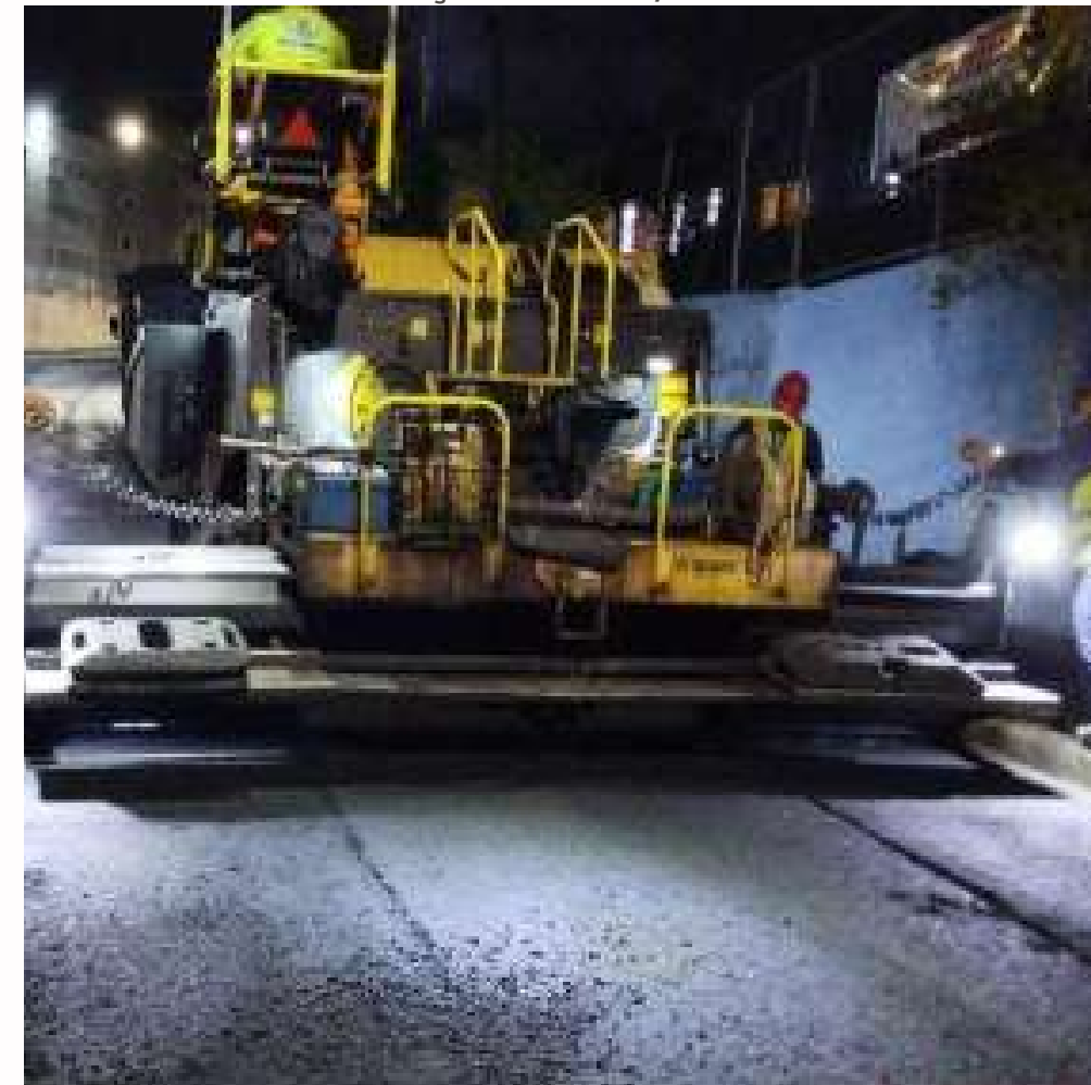
FOTO EM EXECUÇÃO: FEV/2024
