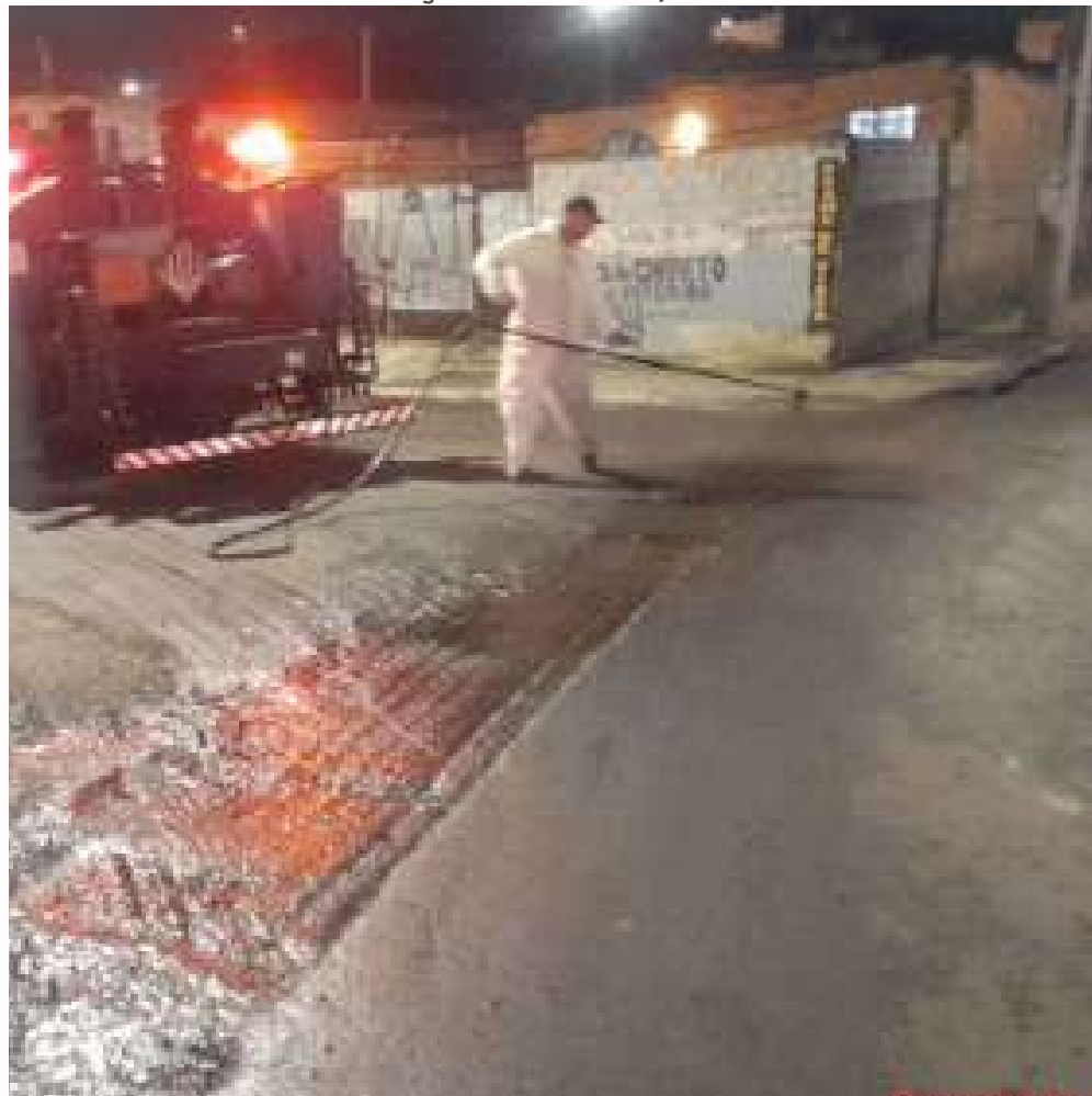
FOTO EM EXECUÇÃO: MAR/2024
