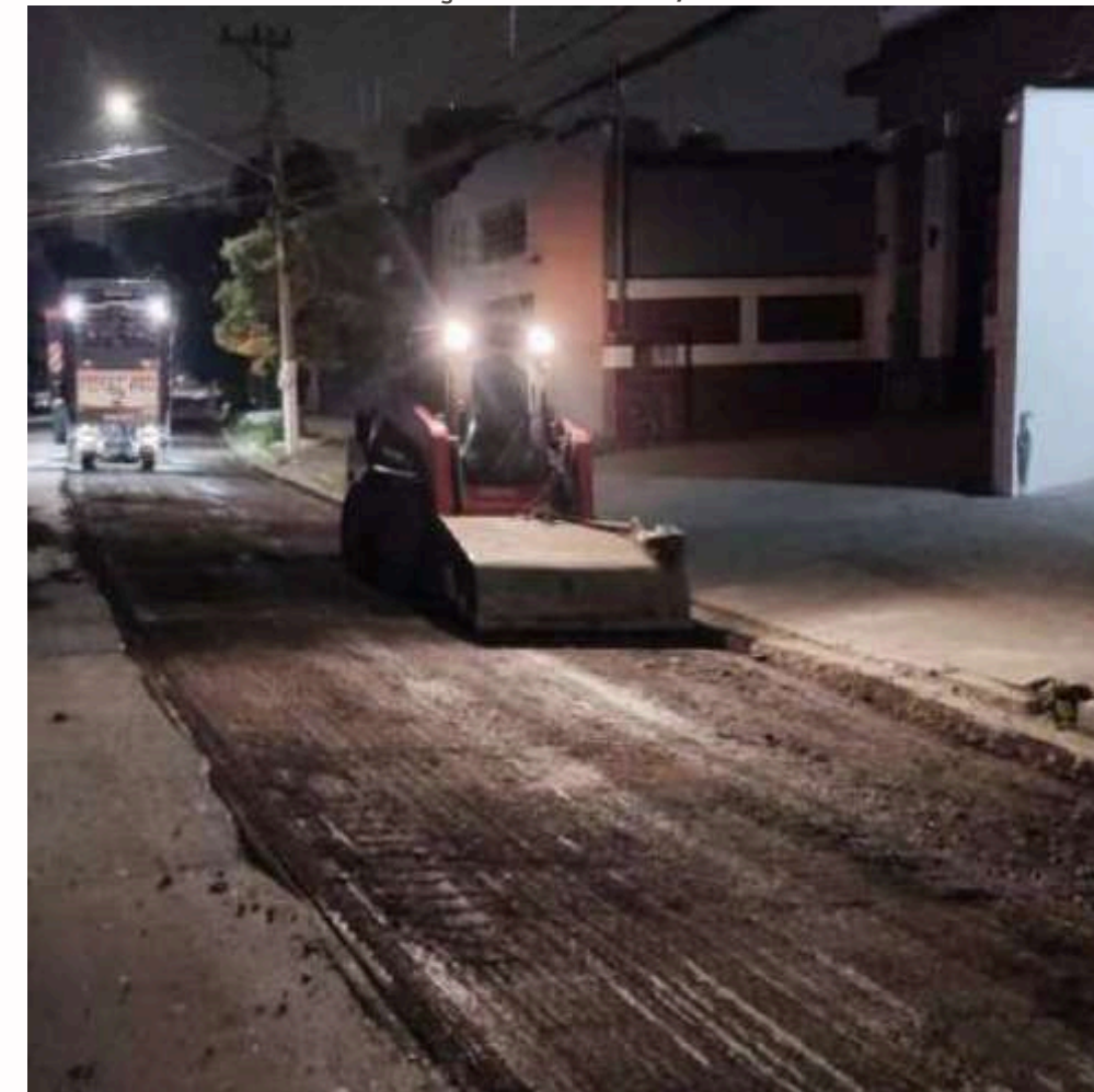
FOTO EM EXECUÇÃO: MAR/2024
