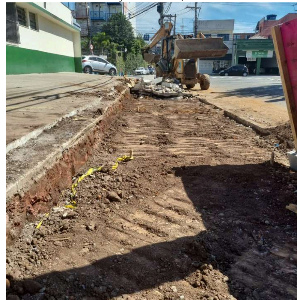
FOTO EM EXECUÇÃO: ABR/2024
