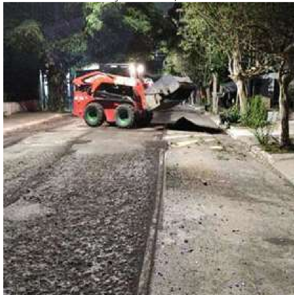
FOTO EM EXECUÇÃO: FEV/2024
