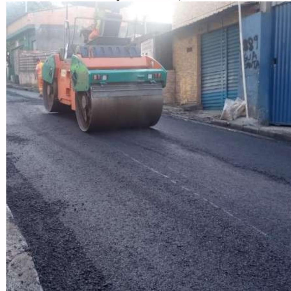
FOTO EM EXECUÇÃO: MAR/2024
