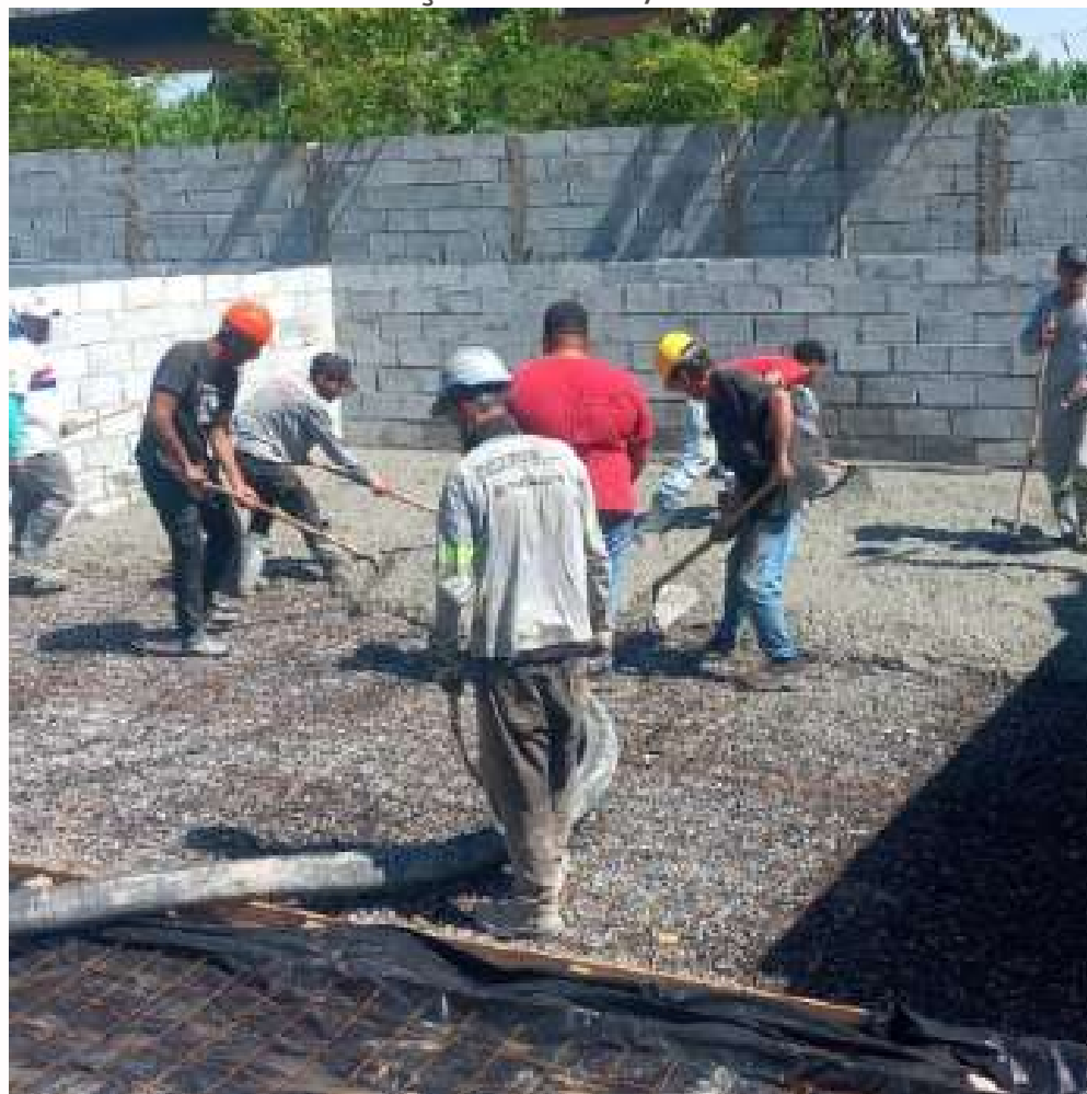
FOTO EM EXECUÇÃO: FEV/2024
