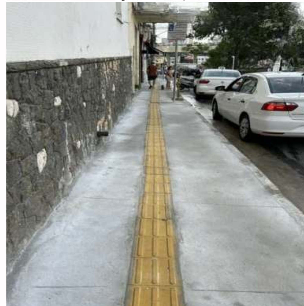
FOTO EM EXECUÇÃO: FEV/2024
