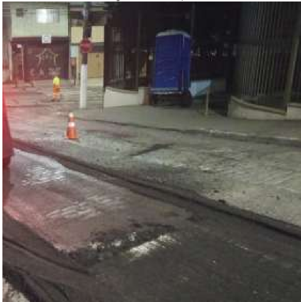
FOTO EM EXECUÇÃO: MAR/2024
