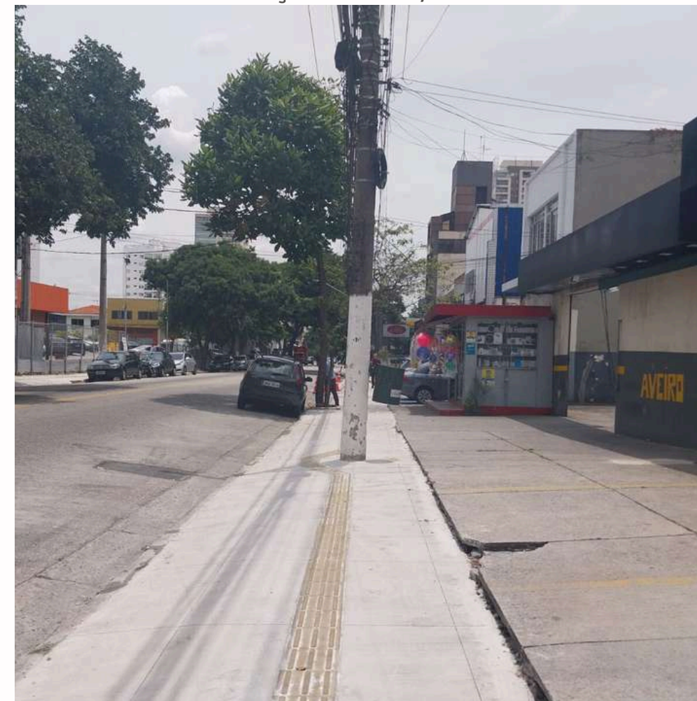
FOTO EM EXECUÇÃO: FEV/2024
