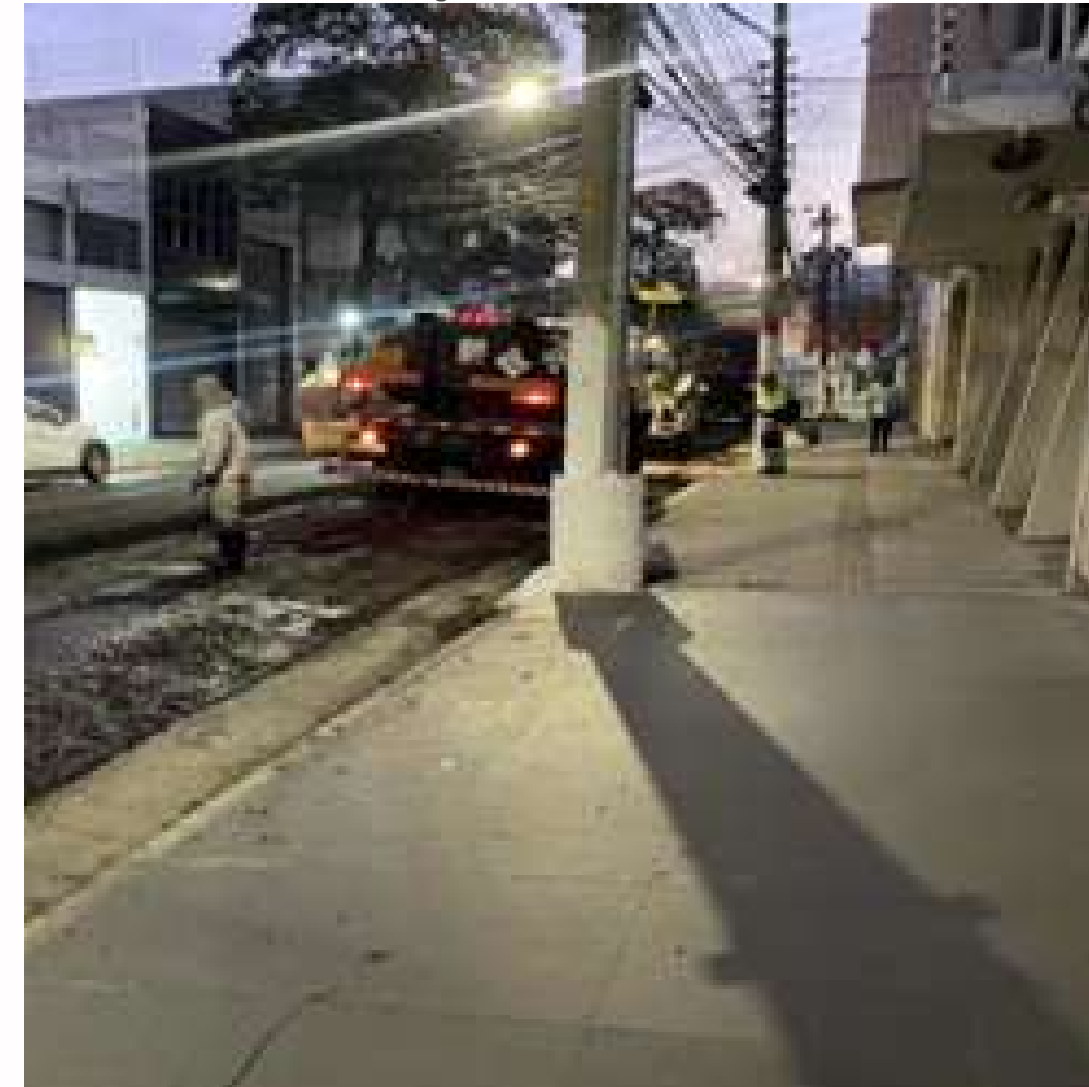
FOTO EM EXECUÇÃO: FEV/2024
