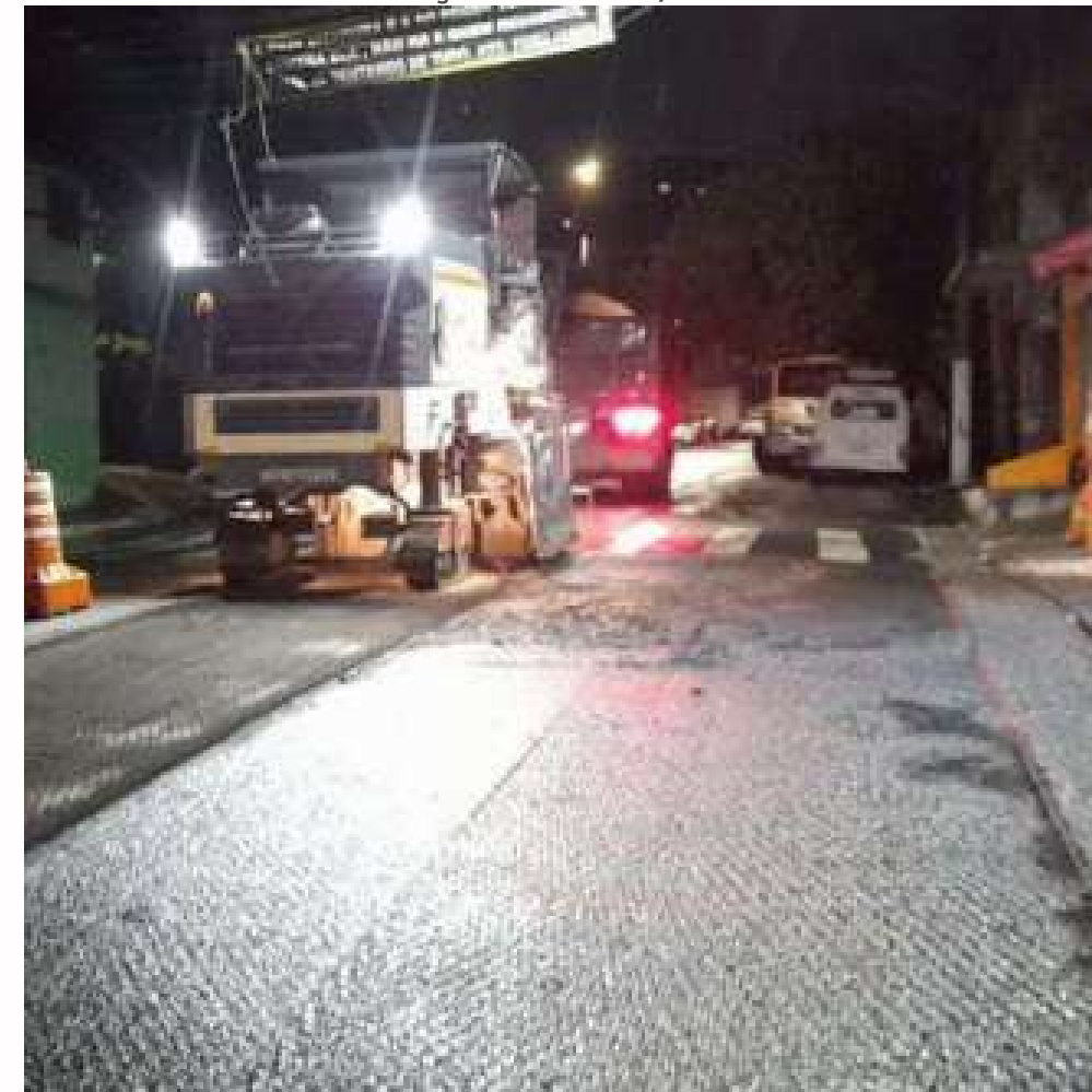
FOTO EM EXECUÇÃO: FEV/2024
