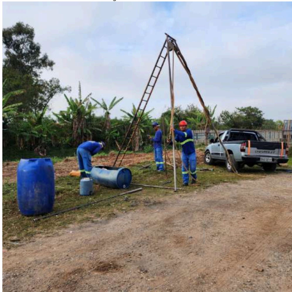
FOTO EM EXECUÇÃO:
