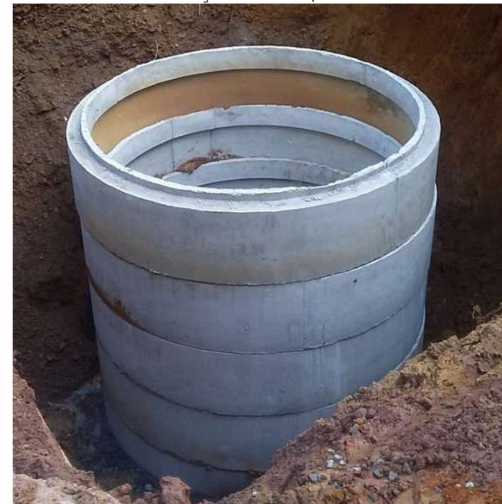
FOTO EM EXECUÇÃO: MAR/2024
