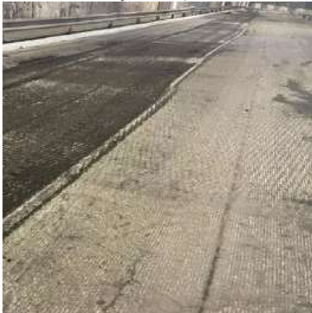
FOTO EM EXECUÇÃO: FEV/2024
