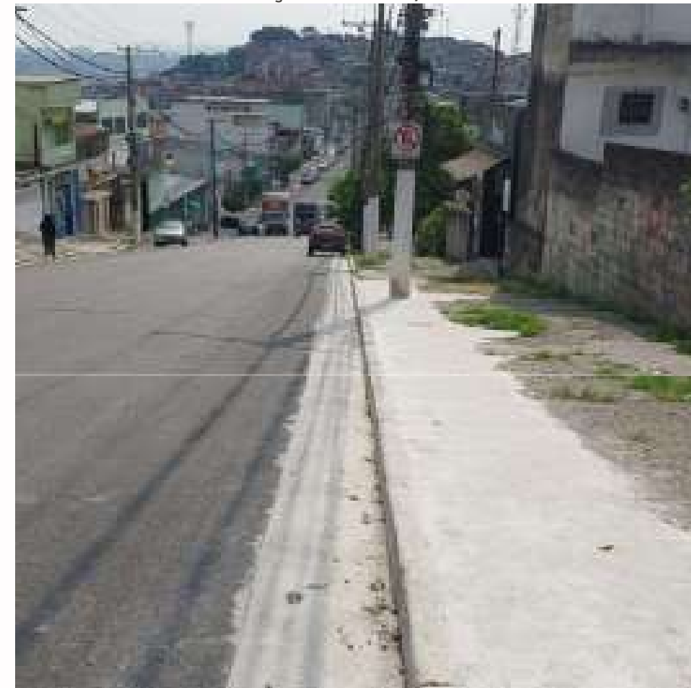
FOTO EM EXECUÇÃO: FEV/2024
