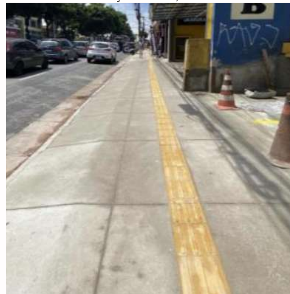
FOTO EM EXECUÇÃO: FEV/2024
