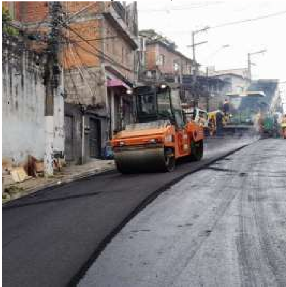
FOTO EM EXECUÇÃO: ABR/2024
