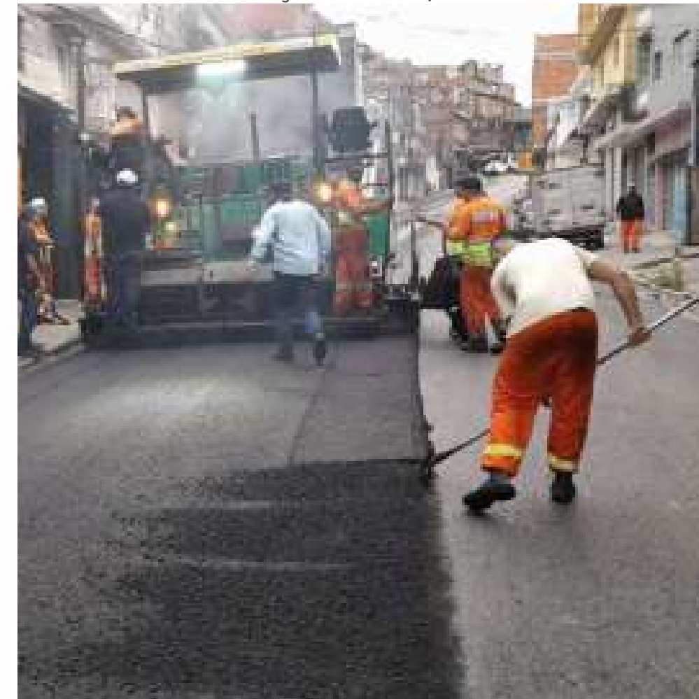
FOTO EM EXECUÇÃO: ABR/2024
