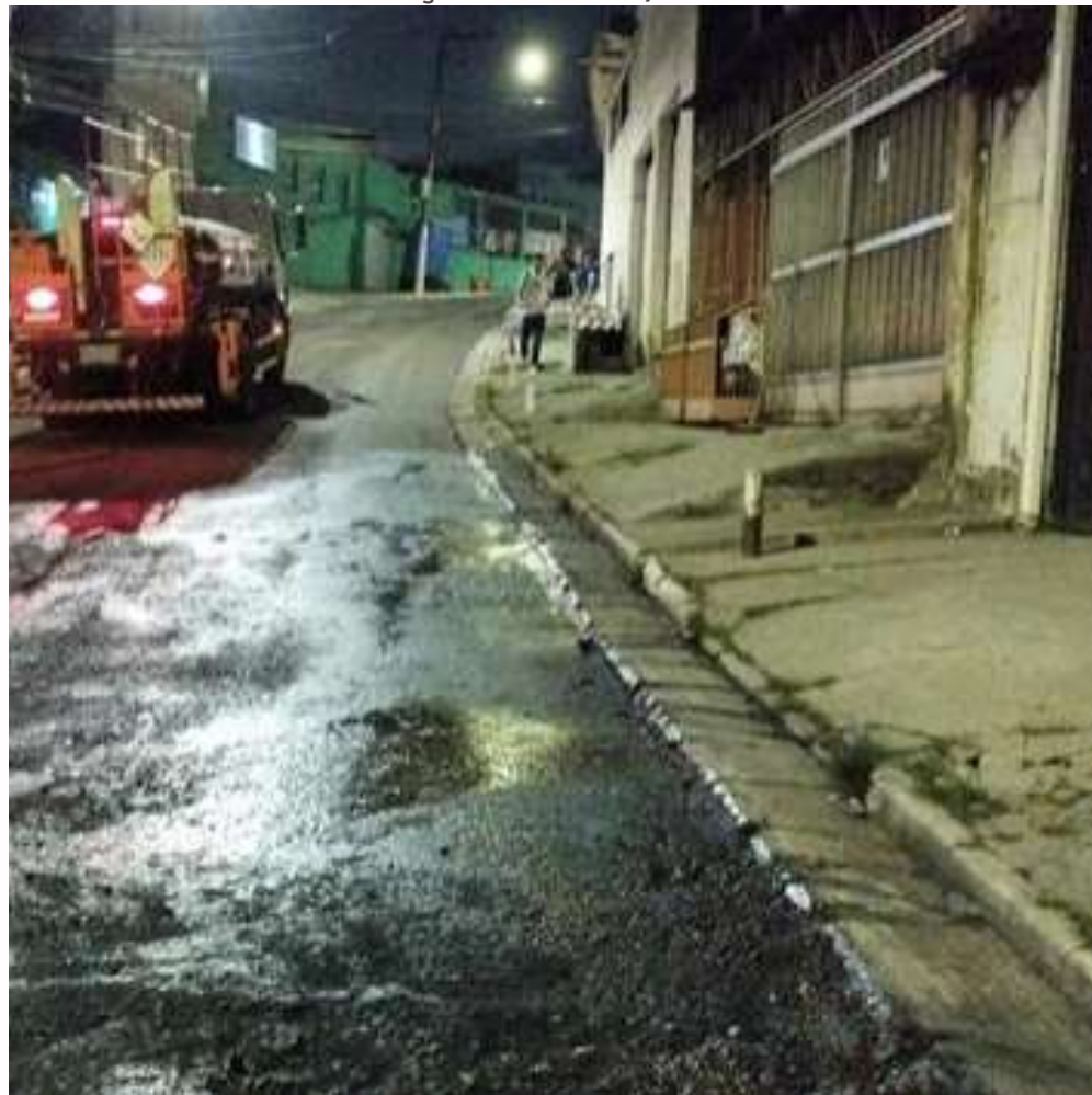
FOTO EM EXECUÇÃO: FEV/2024
