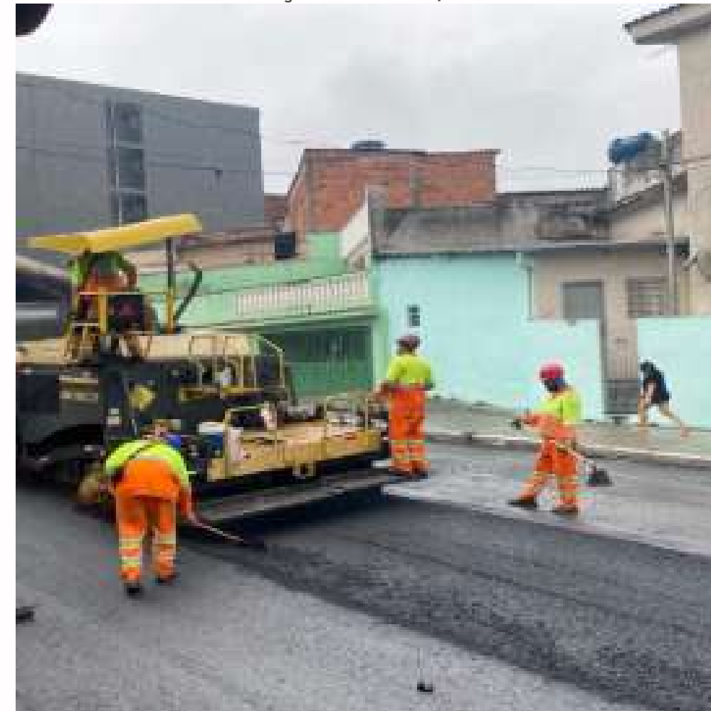
FOTO EM EXECUÇÃO: MAR/2024
