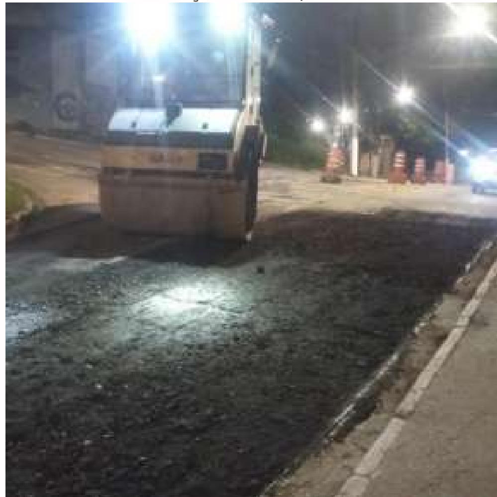
FOTO EM EXECUÇÃO: MAR/2024
