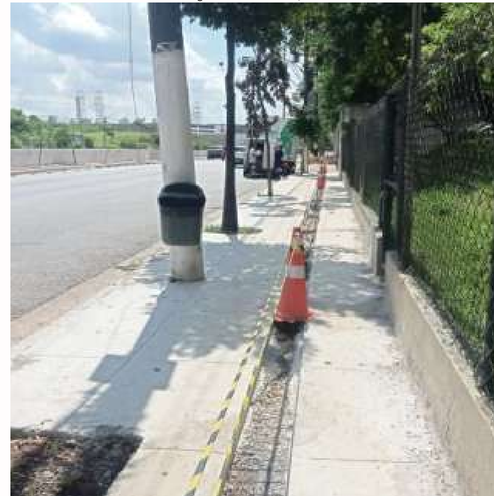
FOTO EM EXECUÇÃO: FEV/2024
