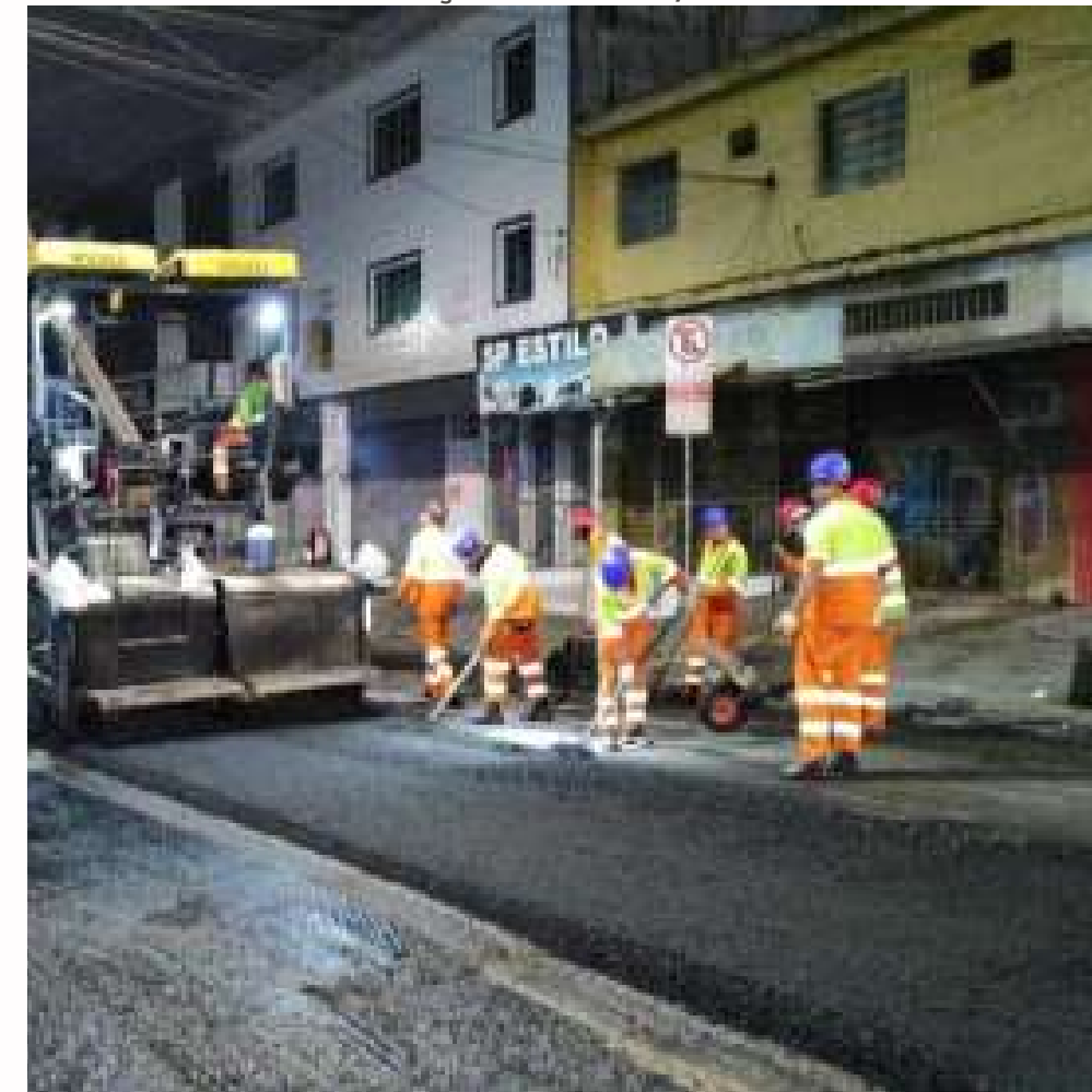
FOTO EM EXECUÇÃO: MAR/2024
