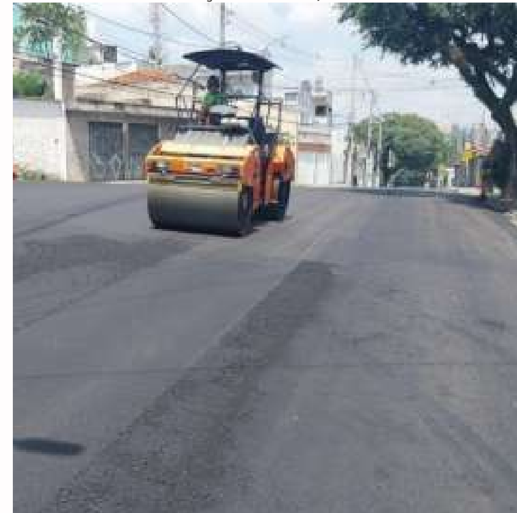
FOTO EM EXECUÇÃO: MAR/2024
