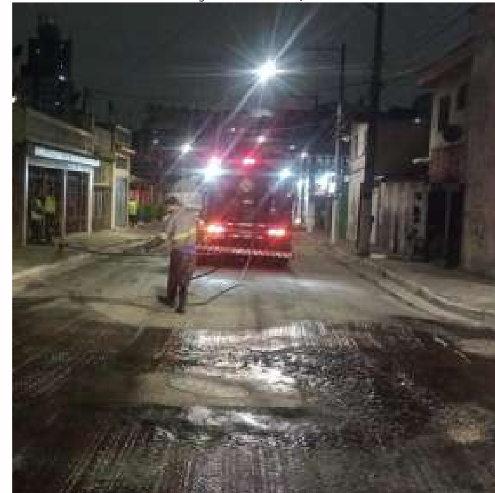
FOTO EM EXECUÇÃO: JAN/2024
