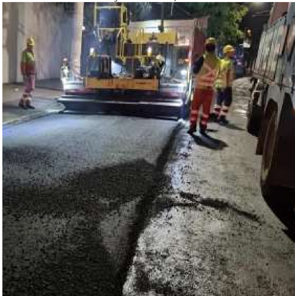
FOTO EM EXECUÇÃO: FEV/2024
