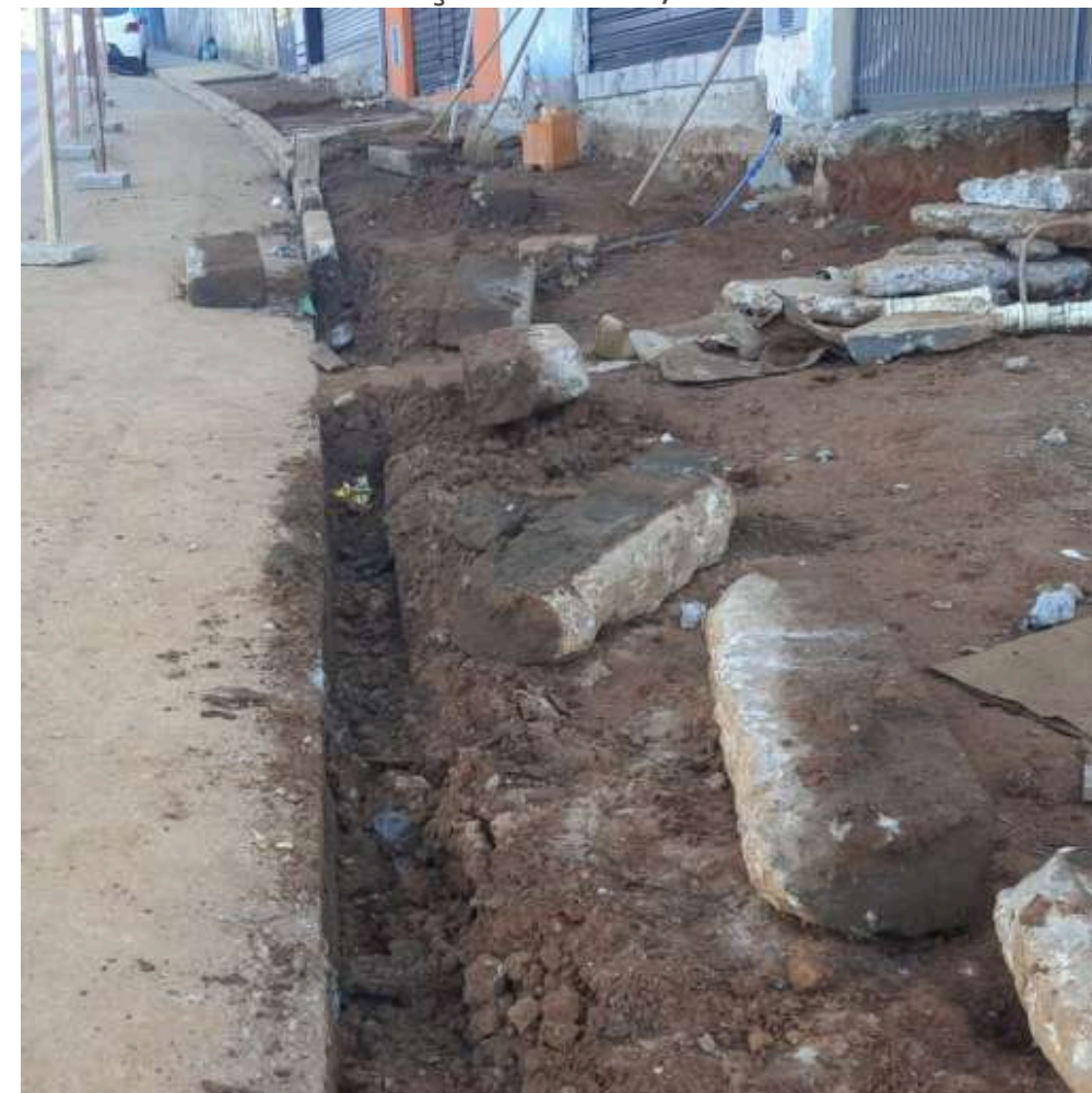
FOTO EM EXECUÇÃO: ABR/2024
