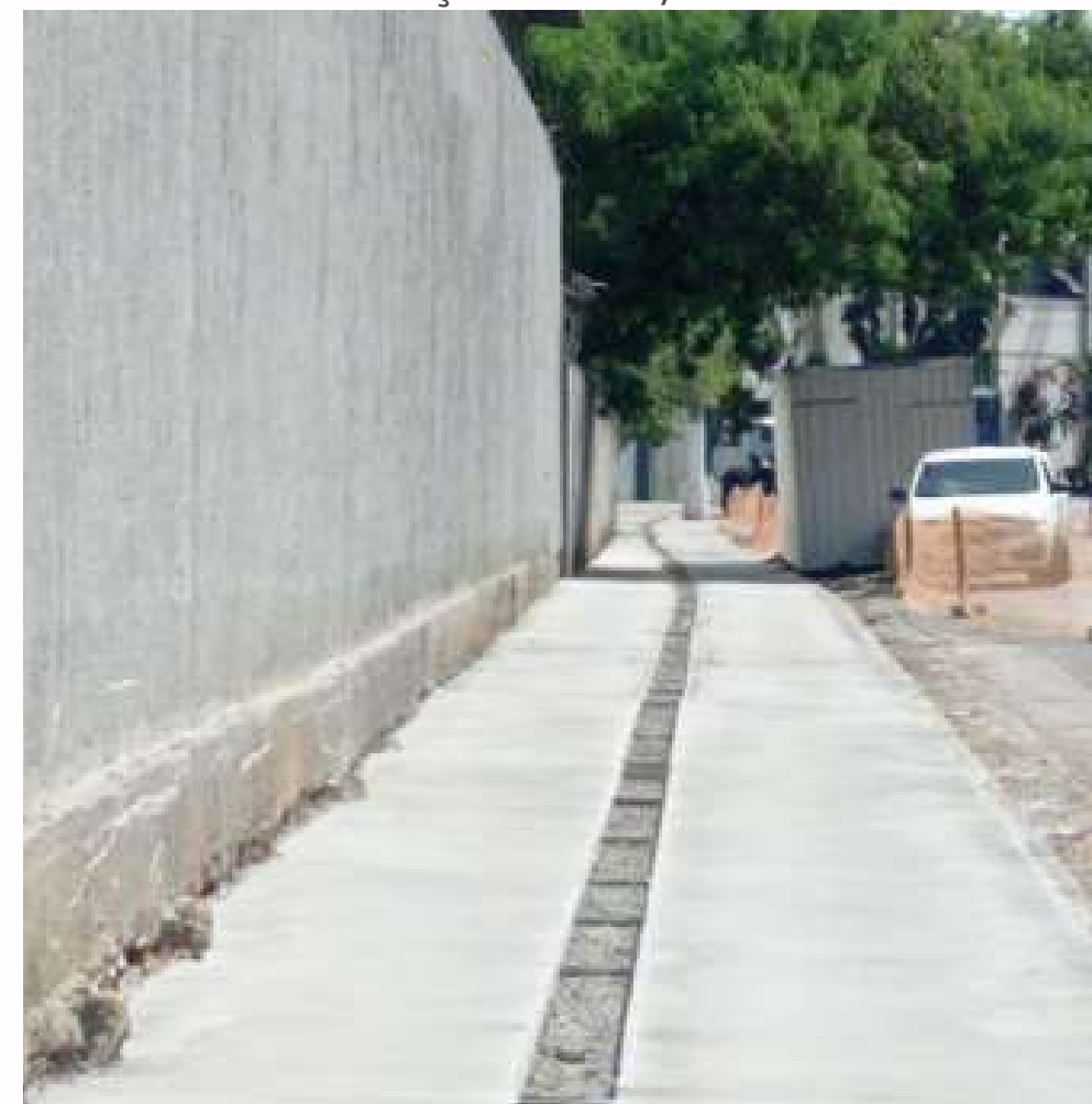
FOTO EM EXECUÇÃO: FEV/2024
