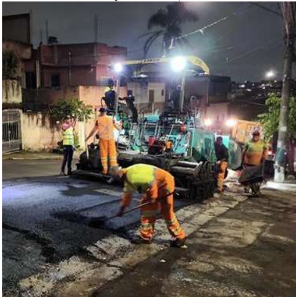
FOTO EM EXECUÇÃO: MAR/2024
