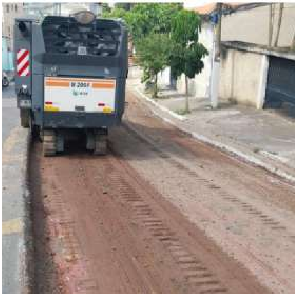
FOTO EM EXECUÇÃO: MAR/2024
