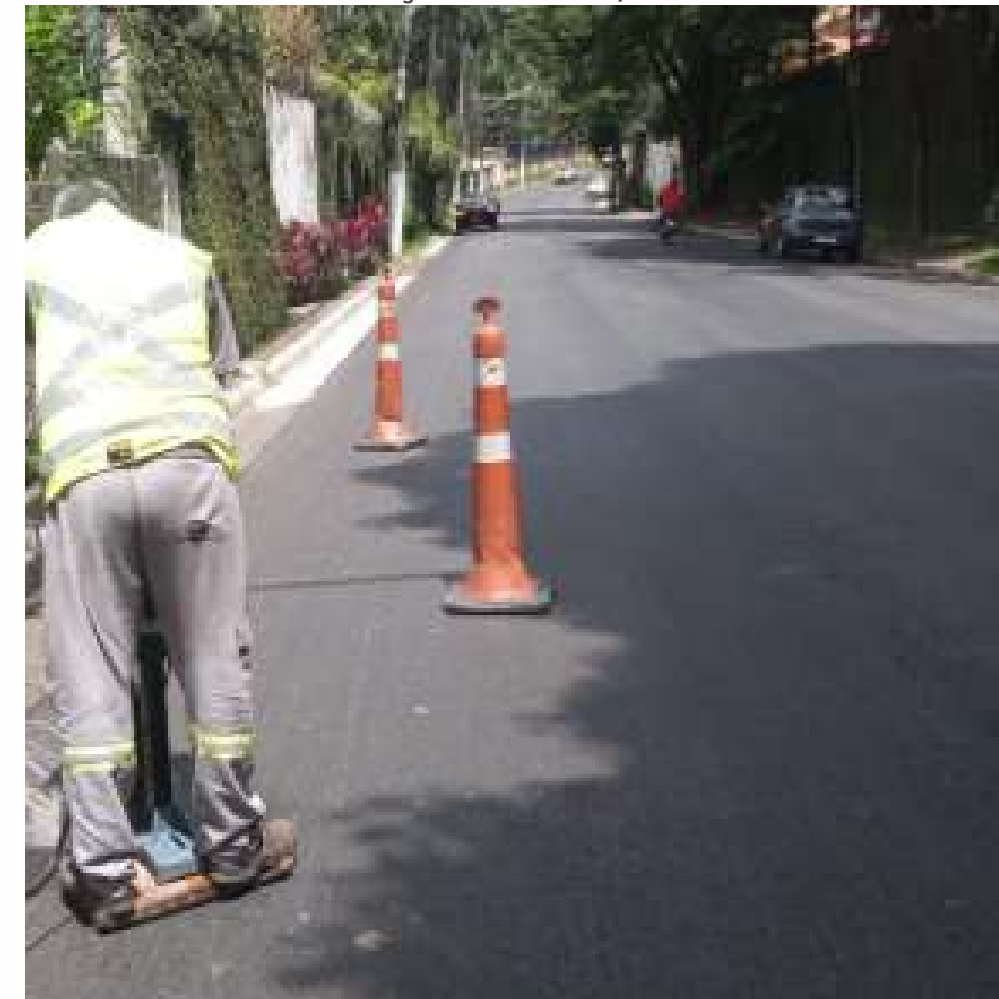
FOTO EM EXECUÇÃO: MAR/2024
