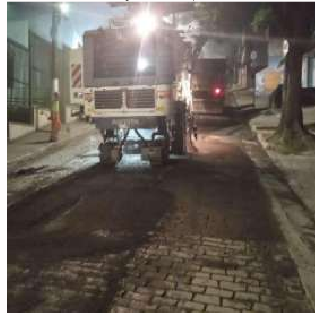
FOTO EM EXECUÇÃO: MAR/2024
