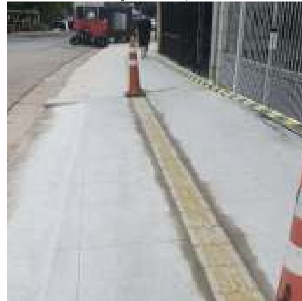
FOTO EM EXECUÇÃO: MAR/2024
