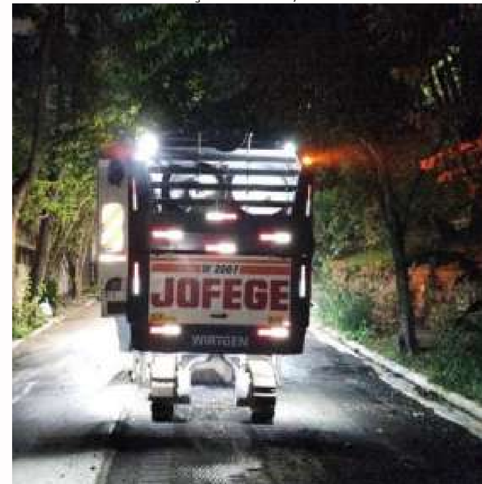
FOTO EM EXECUÇÃO: FEV/2024
