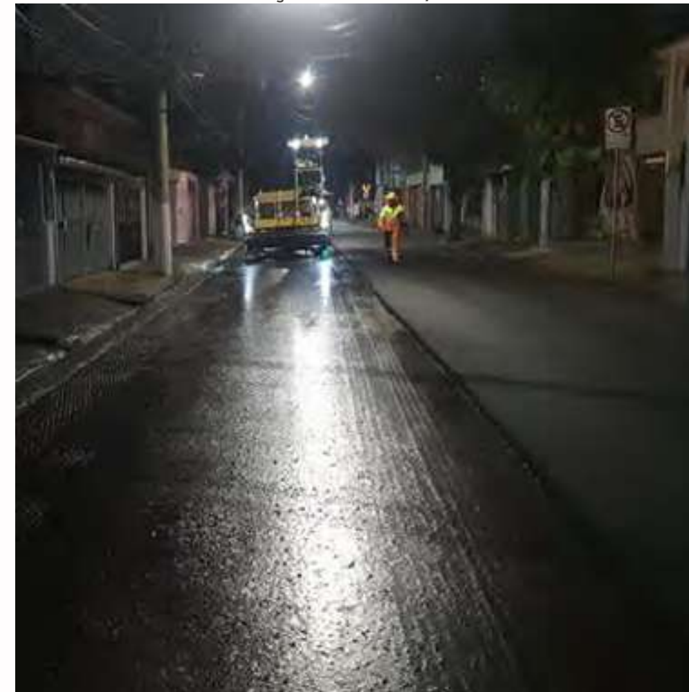
FOTO EM EXECUÇÃO: MAR/2024
