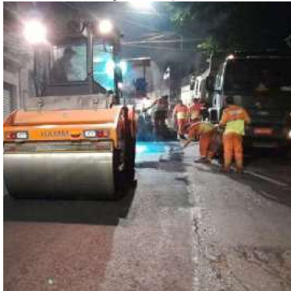
FOTO EM EXECUÇÃO: FEV/2024
