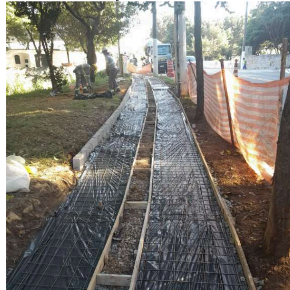
FOTO EM EXECUÇÃO:
