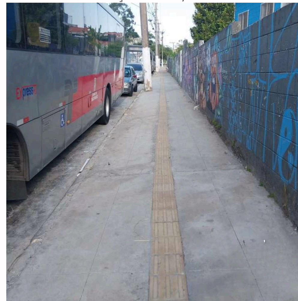
FOTO EM EXECUÇÃO: ABR/2024
