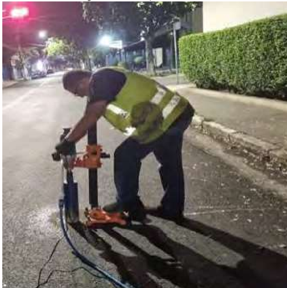
FOTO EXECUÇÃO: MAR/2024
