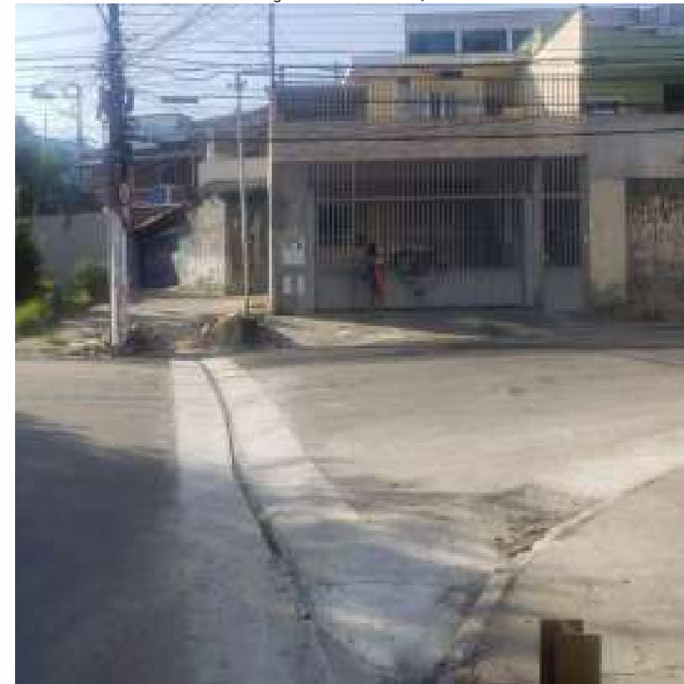
FOTO EM EXECUÇÃO: MAR/2024
