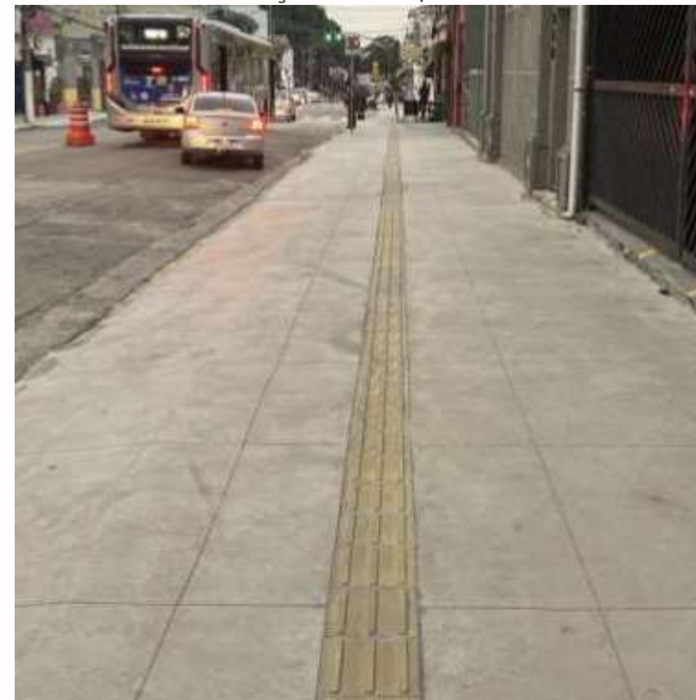
FOTO EM EXECUÇÃO: FEV/2024
