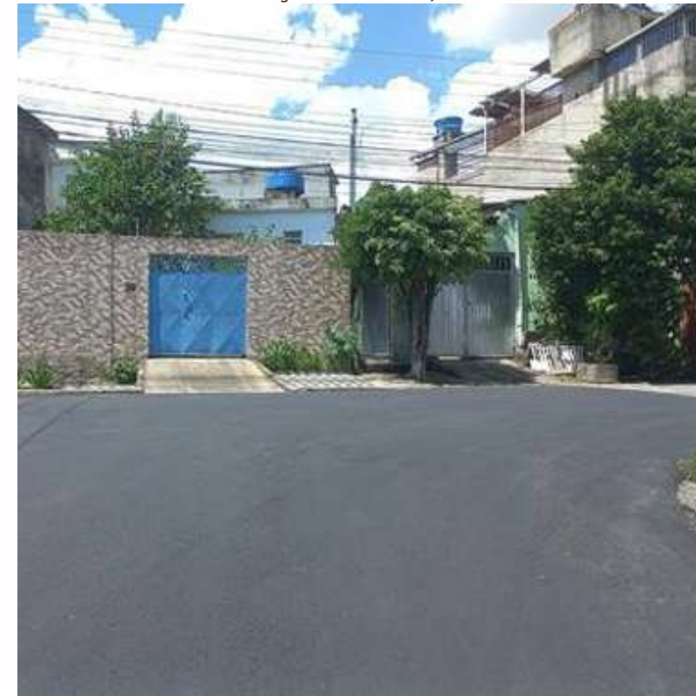
FOTO EM EXECUÇÃO: MAR/2024
