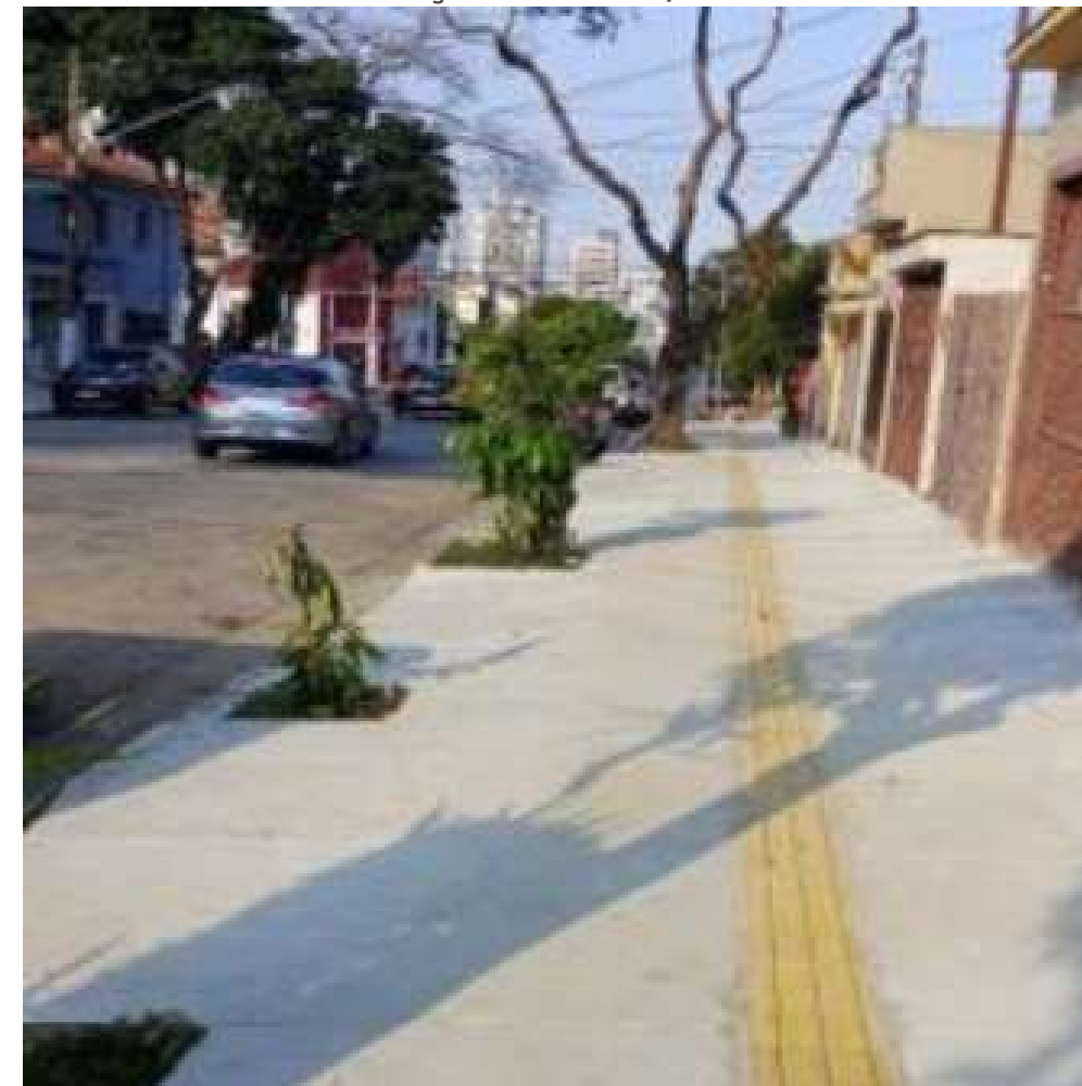
FOTO EM EXECUÇÃO: MAR/2024
