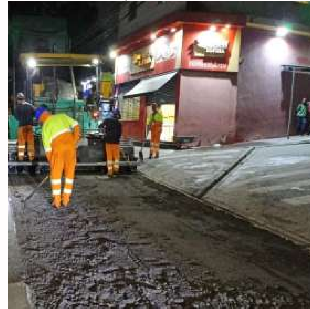
FOTO EM EXECUÇÃO: MAR/2024
