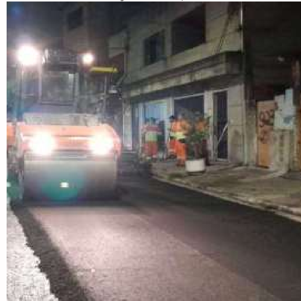
FOTO EM EXECUÇÃO: FEV/2024
