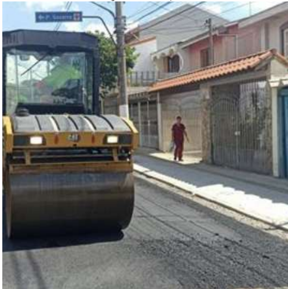
FOTO EM EXECUÇÃO: FEV/2024
