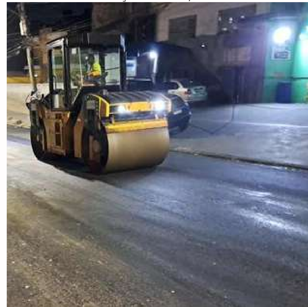
FOTO EM EXECUÇÃO: MAR/2024
