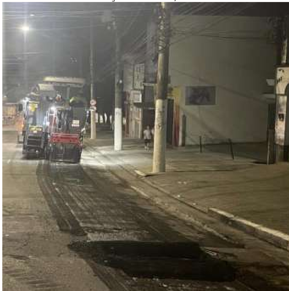
FOTO EM EXECUÇÃO: MAR/2024
