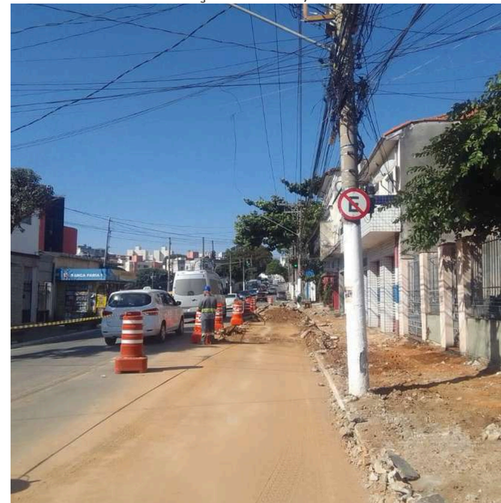
FOTO EM EXECUÇÃO: MAI/2024
