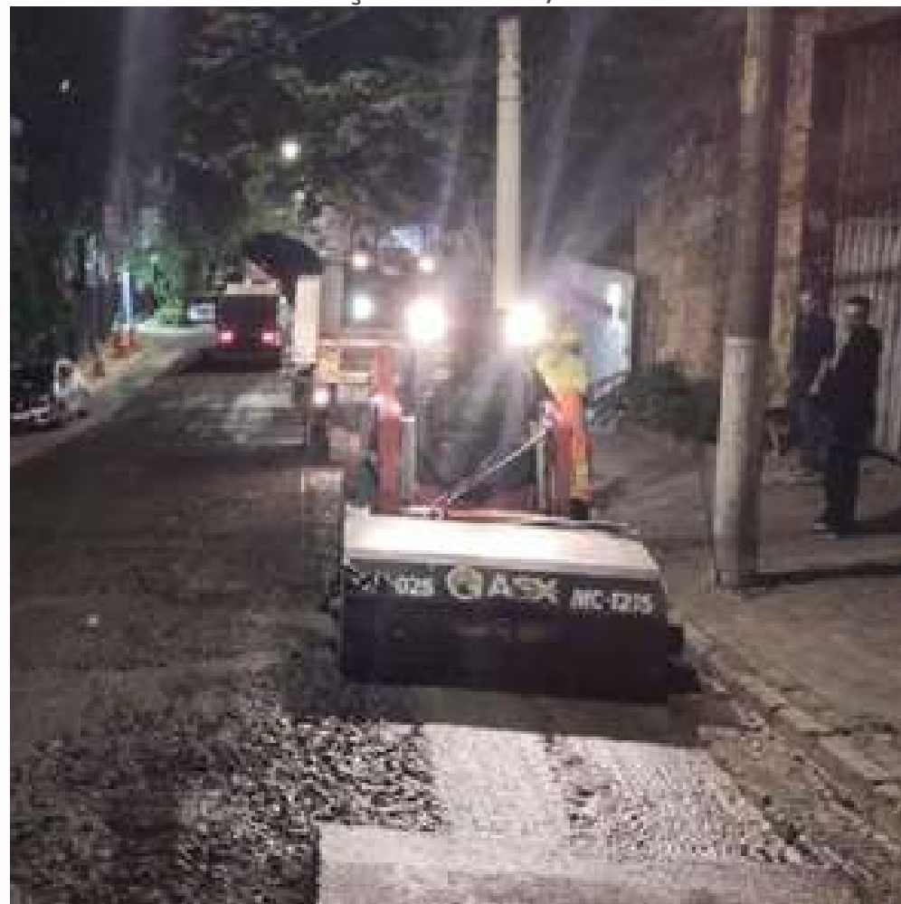
FOTO EM EXECUÇÃO: MAR/2024
