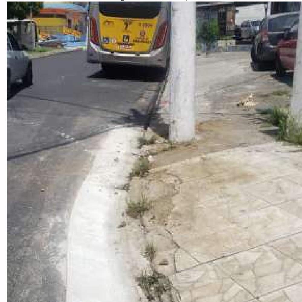
FOTO EM EXECUÇÃO: MAR/2023
