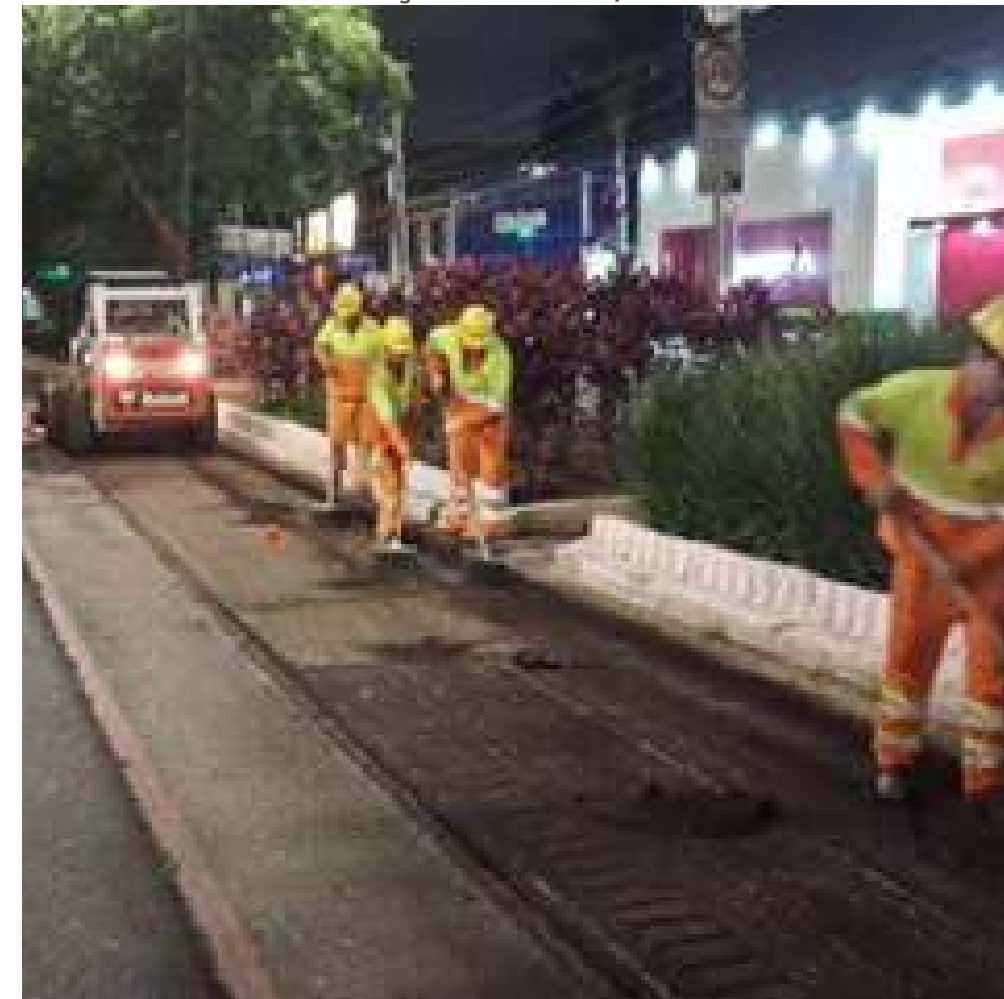
FOTO EM EXECUÇÃO: MAR/2024
