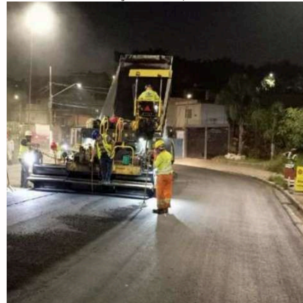
FOTO EM EXECUÇÃO: FEV/2024
