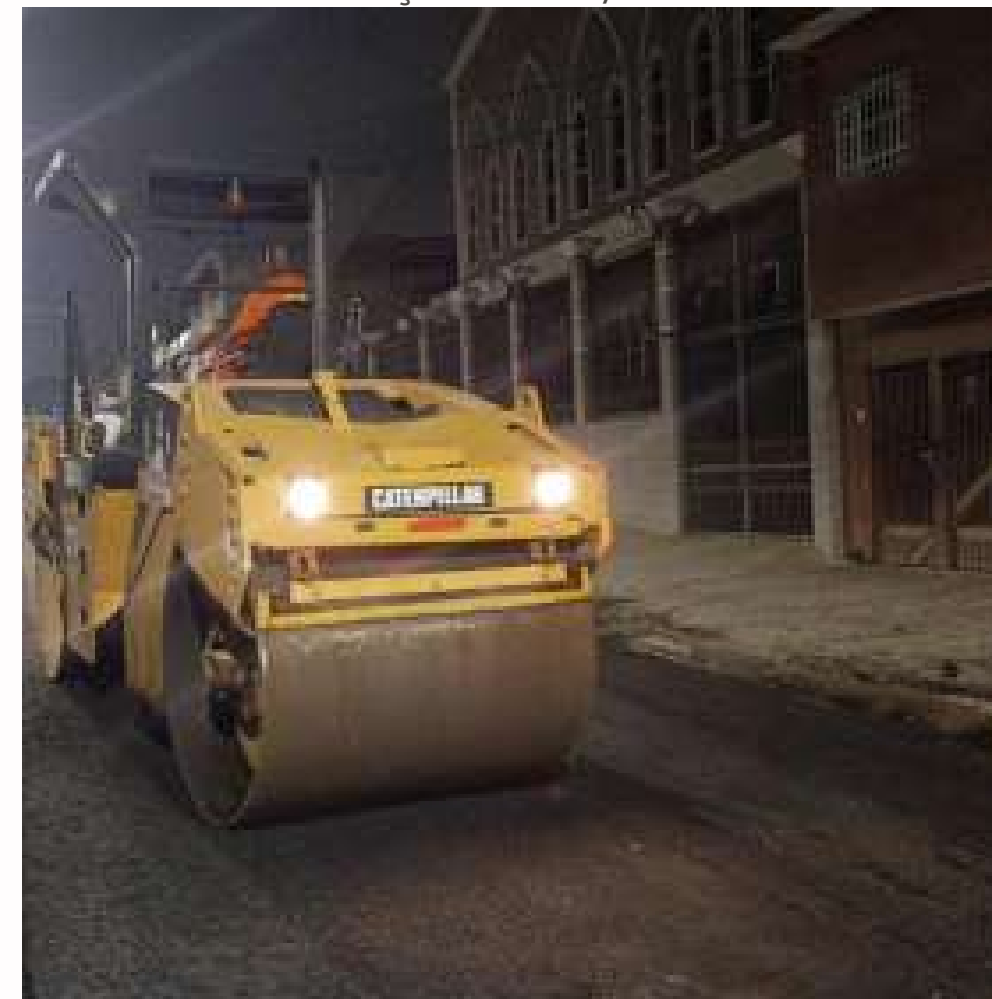
FOTO EM EXECUÇÃO: FEV/2024
