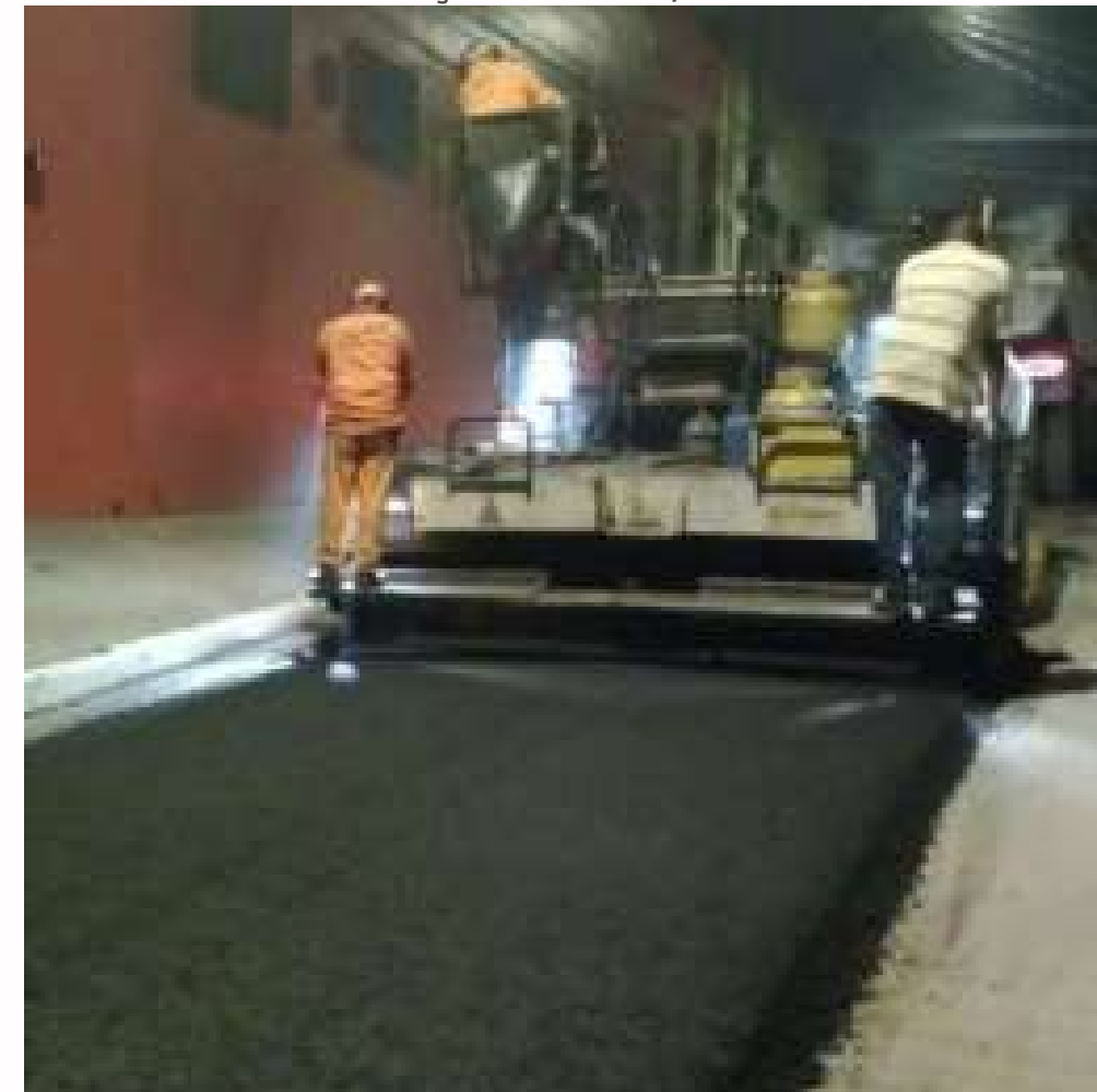
FOTO EM EXECUÇÃO: MAR/2024
