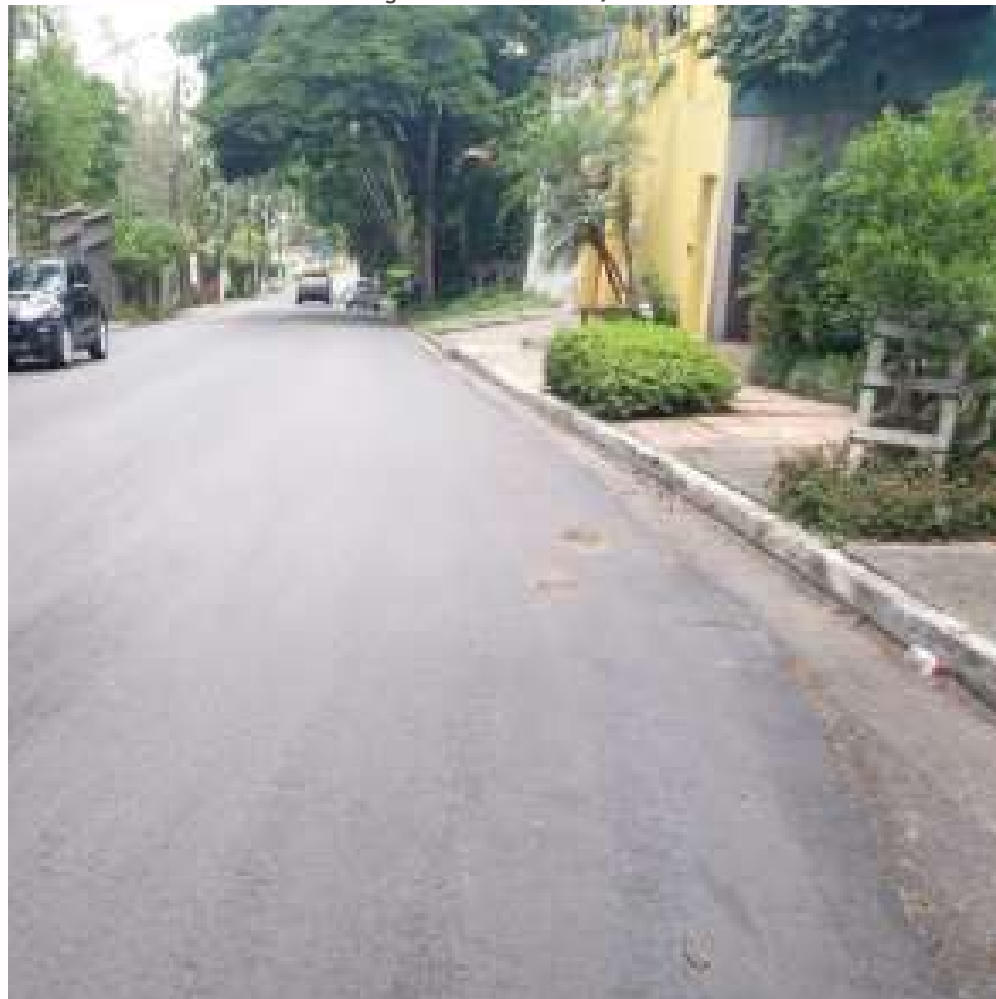
FOTO EM EXECUÇÃO: MAR/2024
