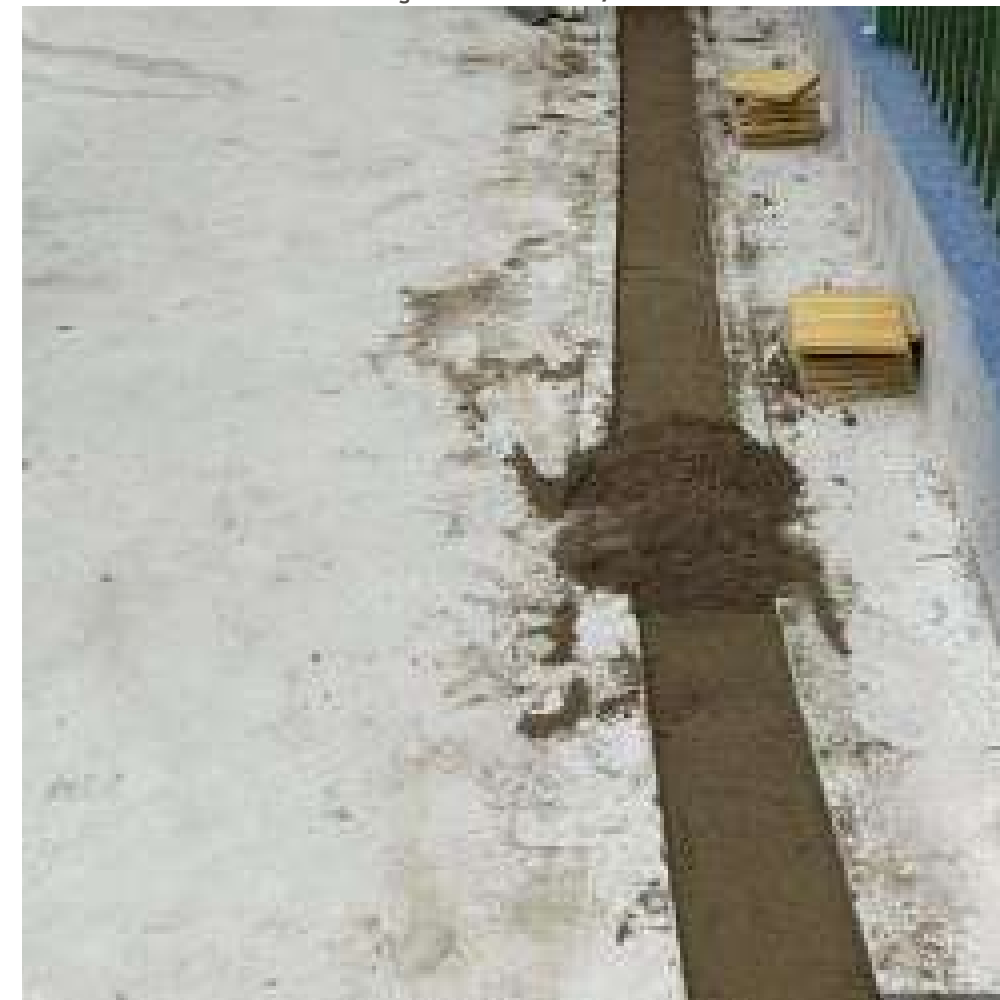
FOTO EM EXECUÇÃO: FEV/2024
