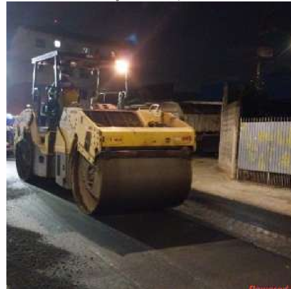
FOTO EM EXECUÇÃO: MAR/2024
