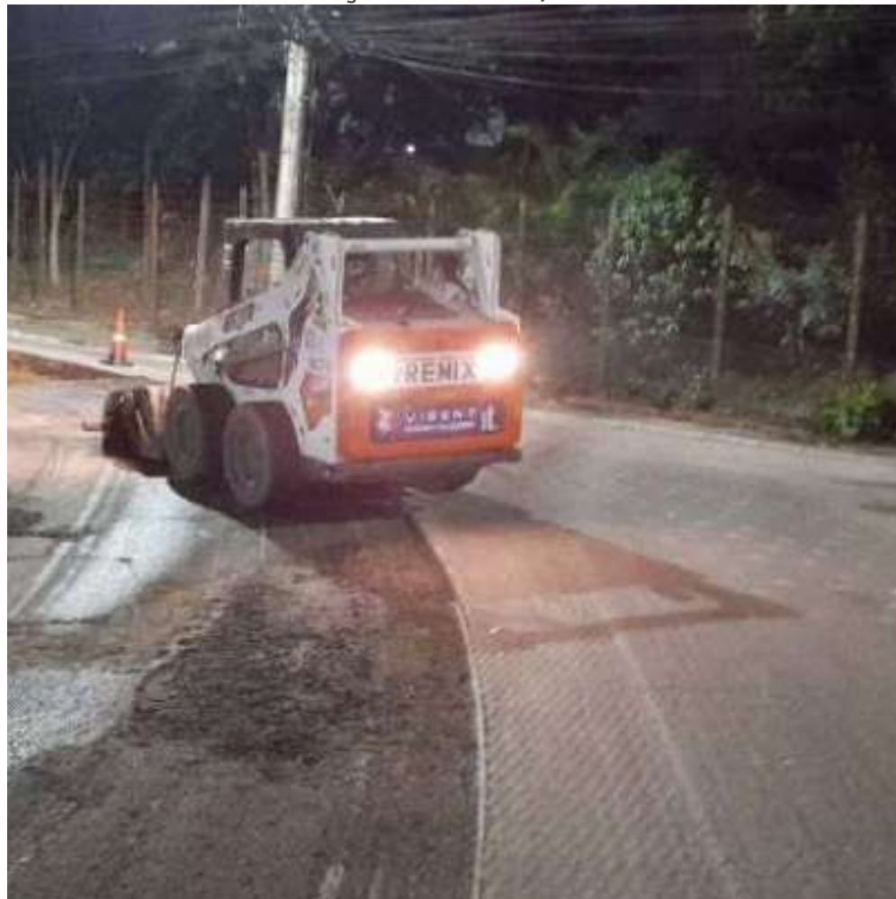
FOTO EM EXECUÇÃO: MAR/2024
