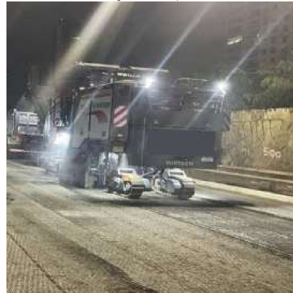
FOTO EM EXECUÇÃO: FEV/2024
