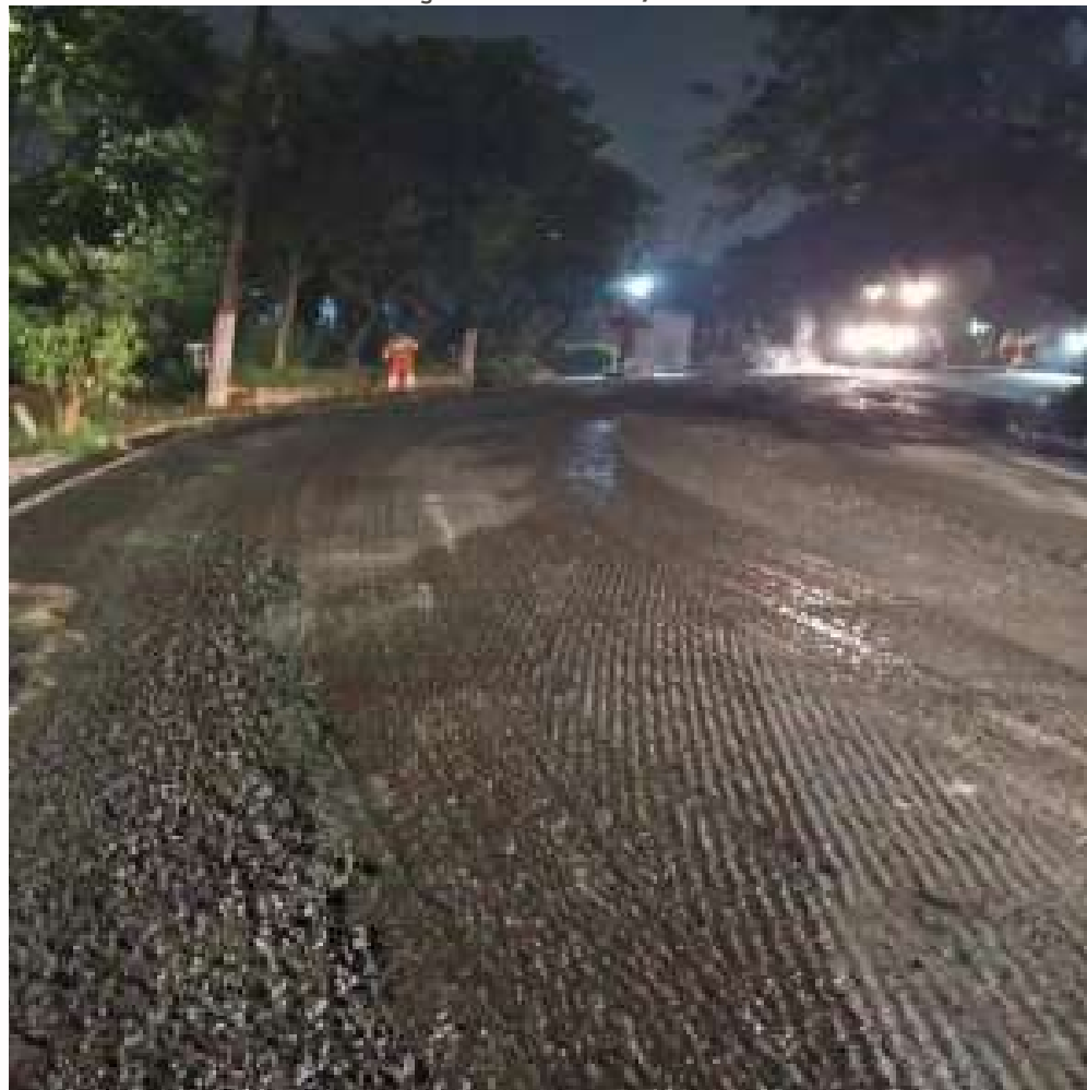
FOTO EM EXECUÇÃO: FEV/2024
