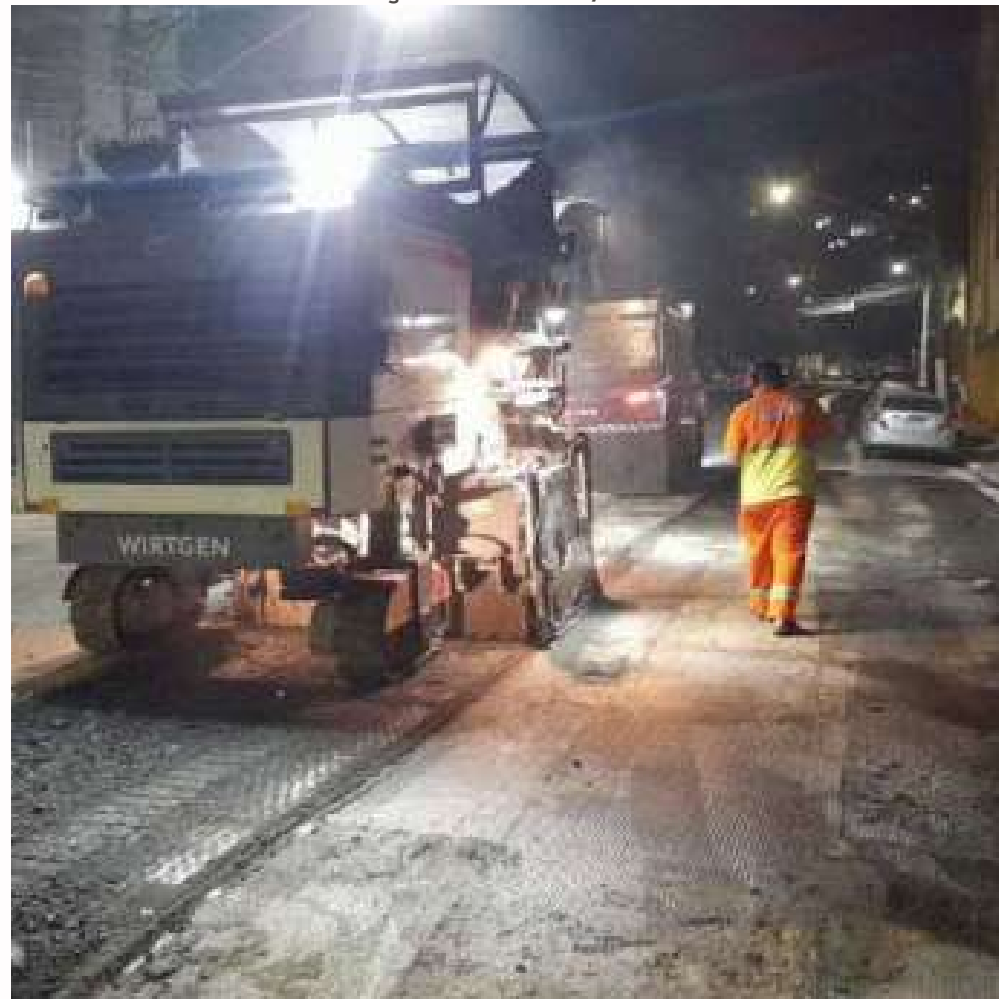
FOTO EM EXECUÇÃO: FEV/2024
