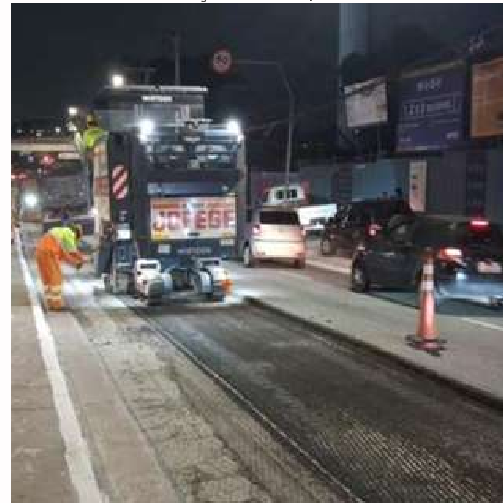
FOTO EM EXECUÇÃO: MAR/2024
